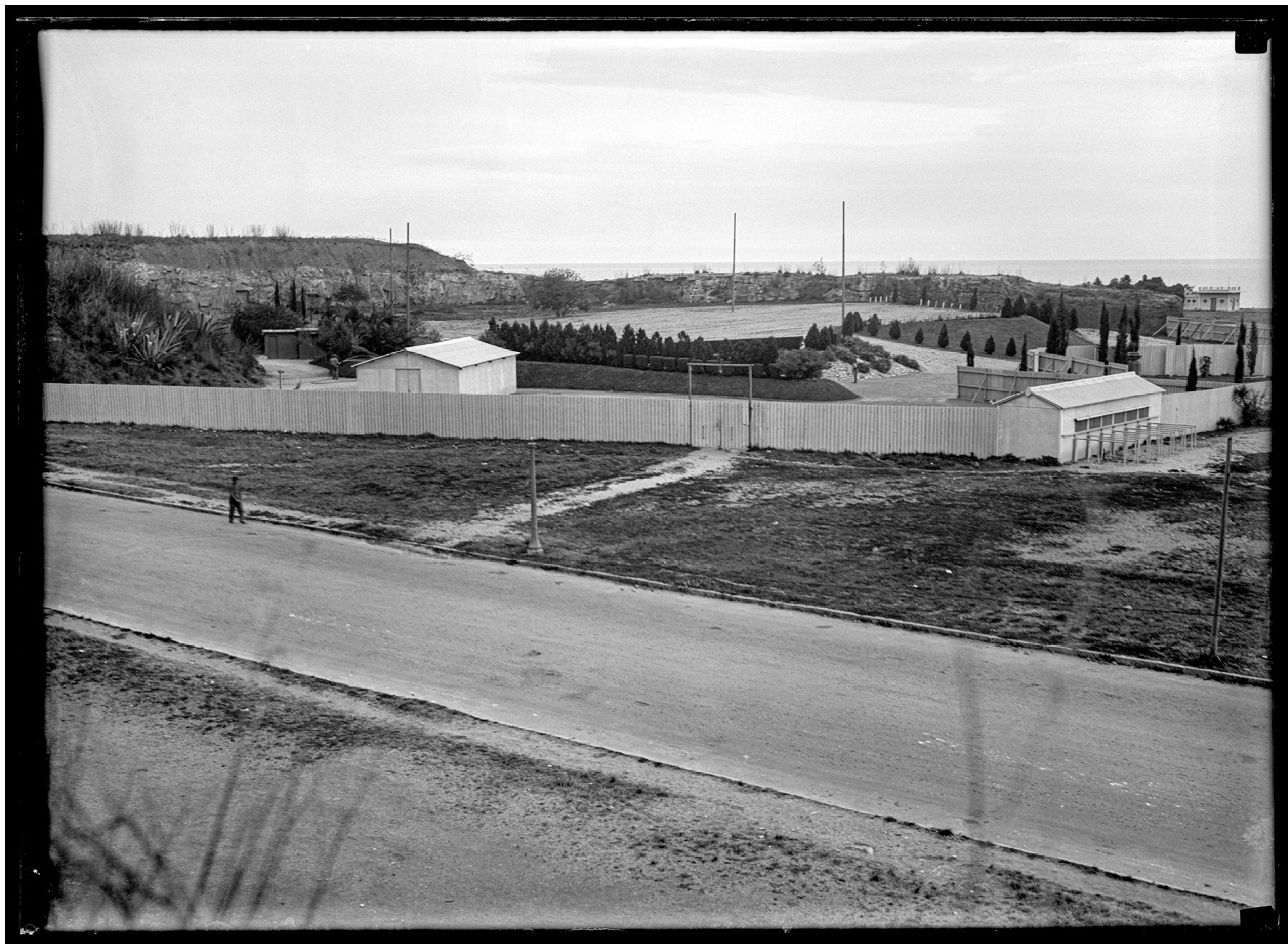
Construcción del Teatro de Verano. Año 1943.
