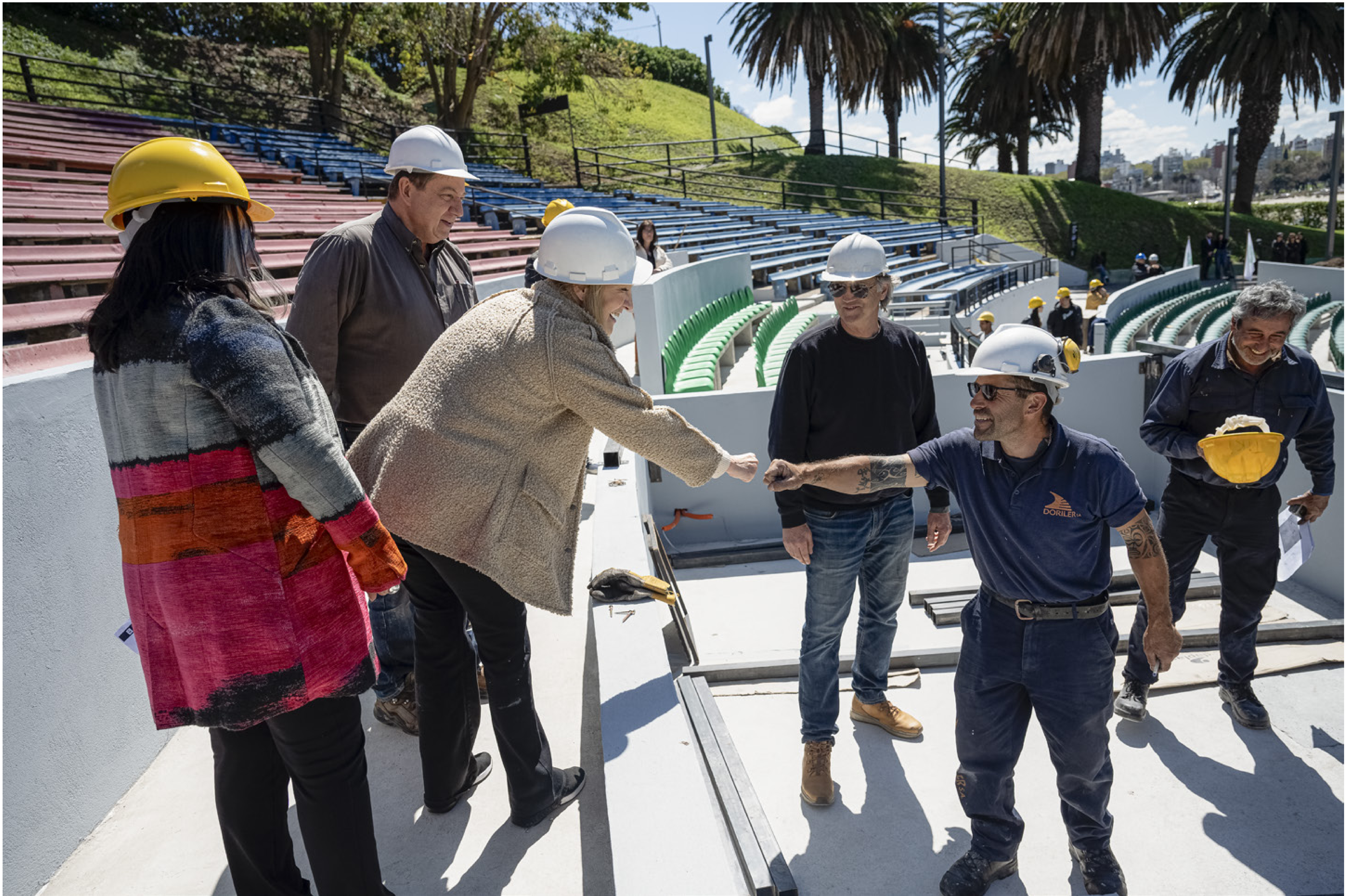
A la izquierda, María Inés Obaldía y Carolina Cosse. Visita de la intendenta Carolina Cosse, durante la obra de la primera etapa de remodelación del Teatro de Verano. (Foto: 20230927DICIMOUYSM32073 – Autor: Santiago Mazzarovich / División de Información y Comunicación – Intendencia de Montevideo).
