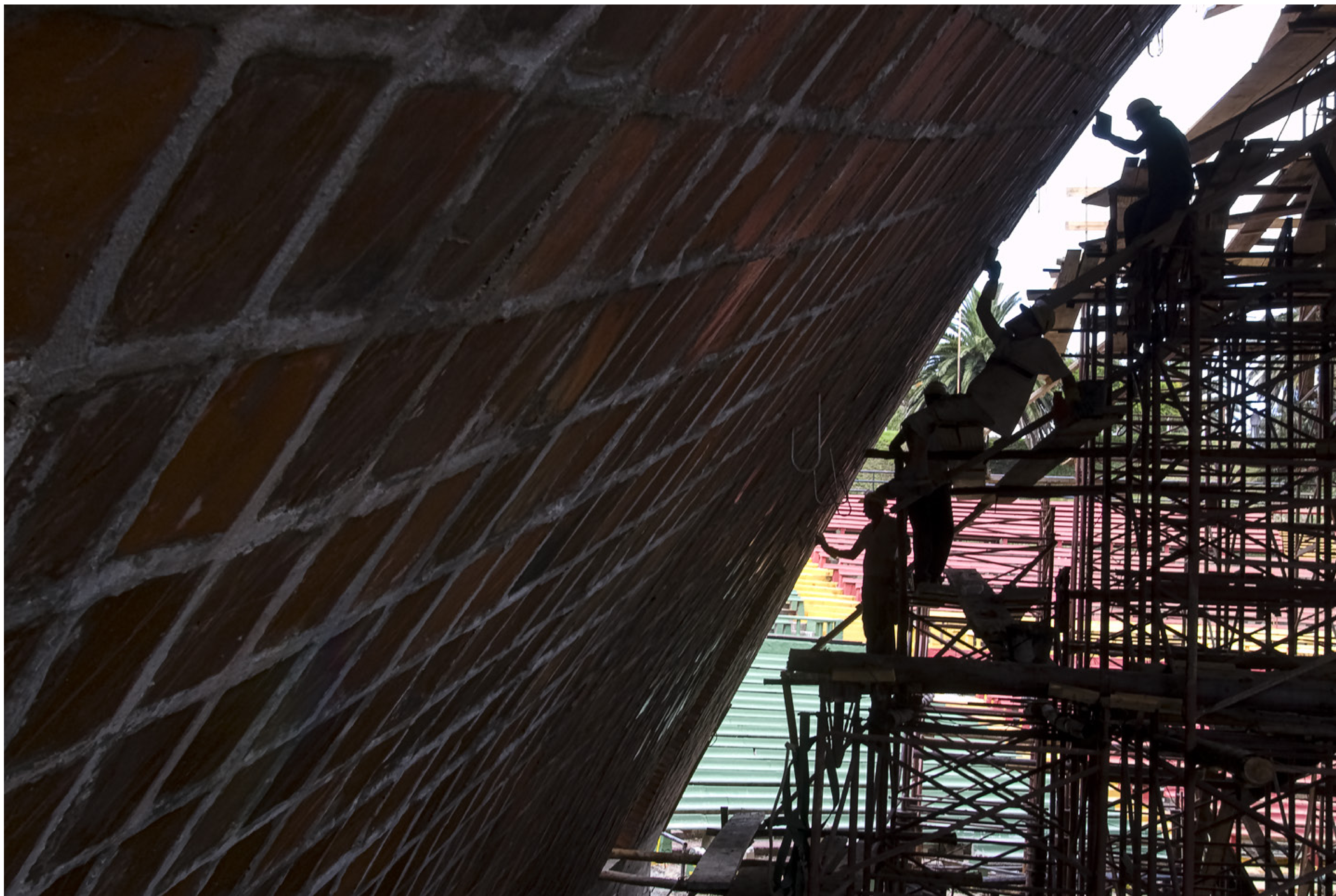
Trabajos de finalización de la construcción interior de la bóveda. Teatro de Verano. 19 de diciembre de 2006. (Foto: 20082FMCMA.CDFIMO.UY – Autor: Carlos Contrera / Centro de Fotografía – Intendencia de Montevideo).
