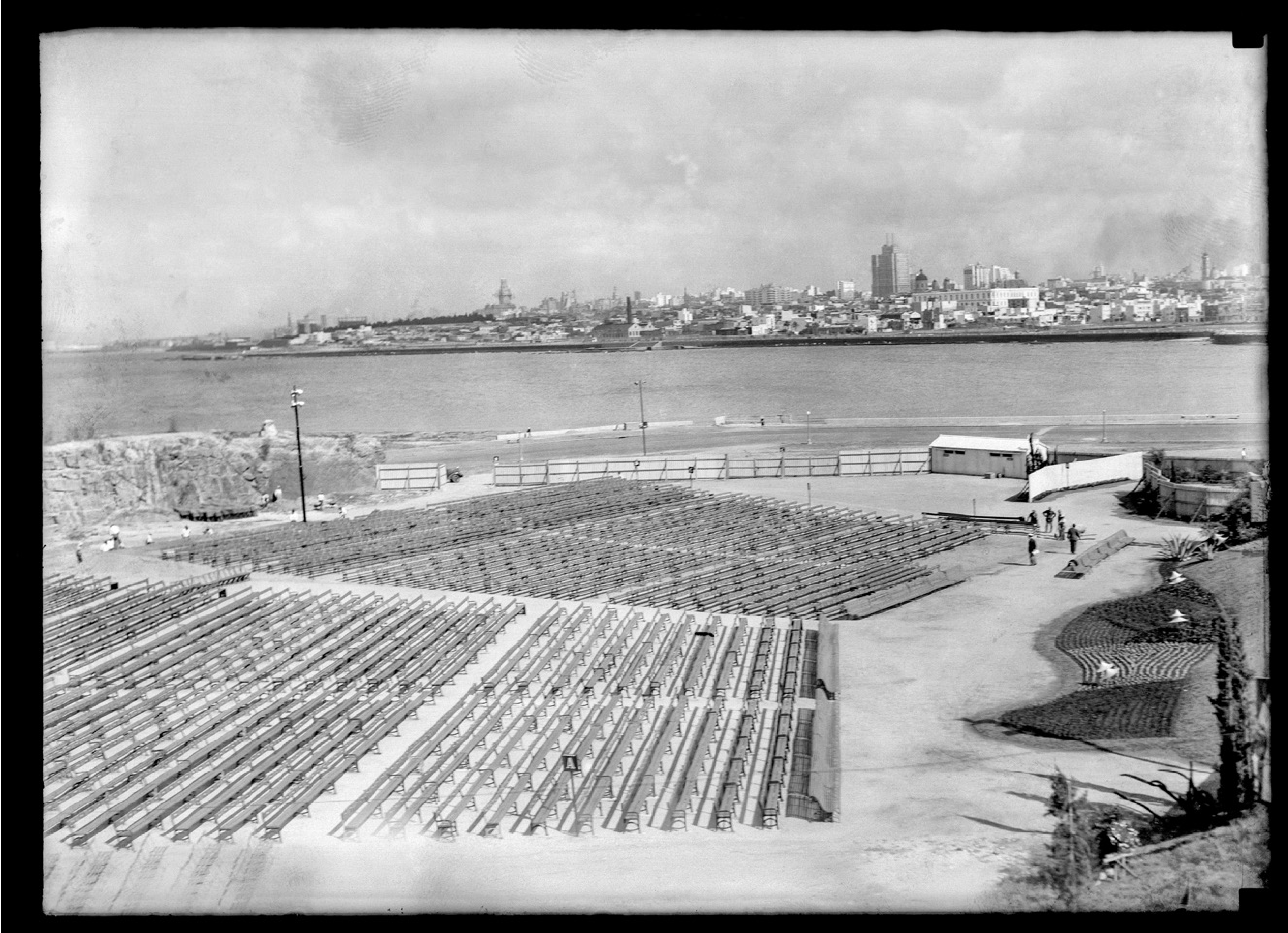
Construcción del Teatro de Verano. Año 1943-1944. (Foto: 23463FMHGE.CDFIMO.UY – Autor: Fotógrafos municipales / Centro de Fotografía – Intendencia de Montevideo).
