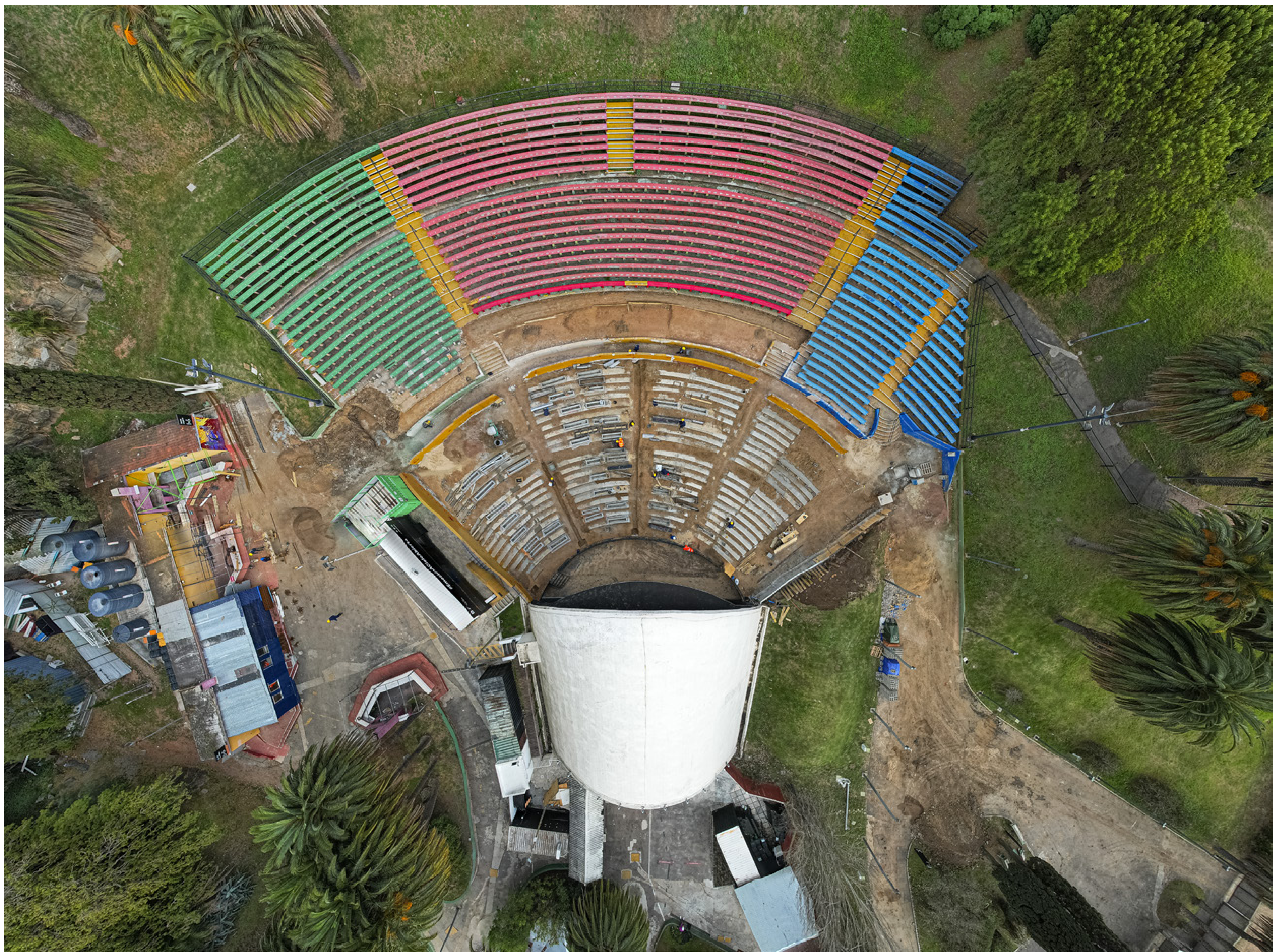
Vista aérea del proceso de reforma de la primera etapa de obras del Teatro de Verano. 4 de julio de 2023. (Autor: Mauro Cardozo).
