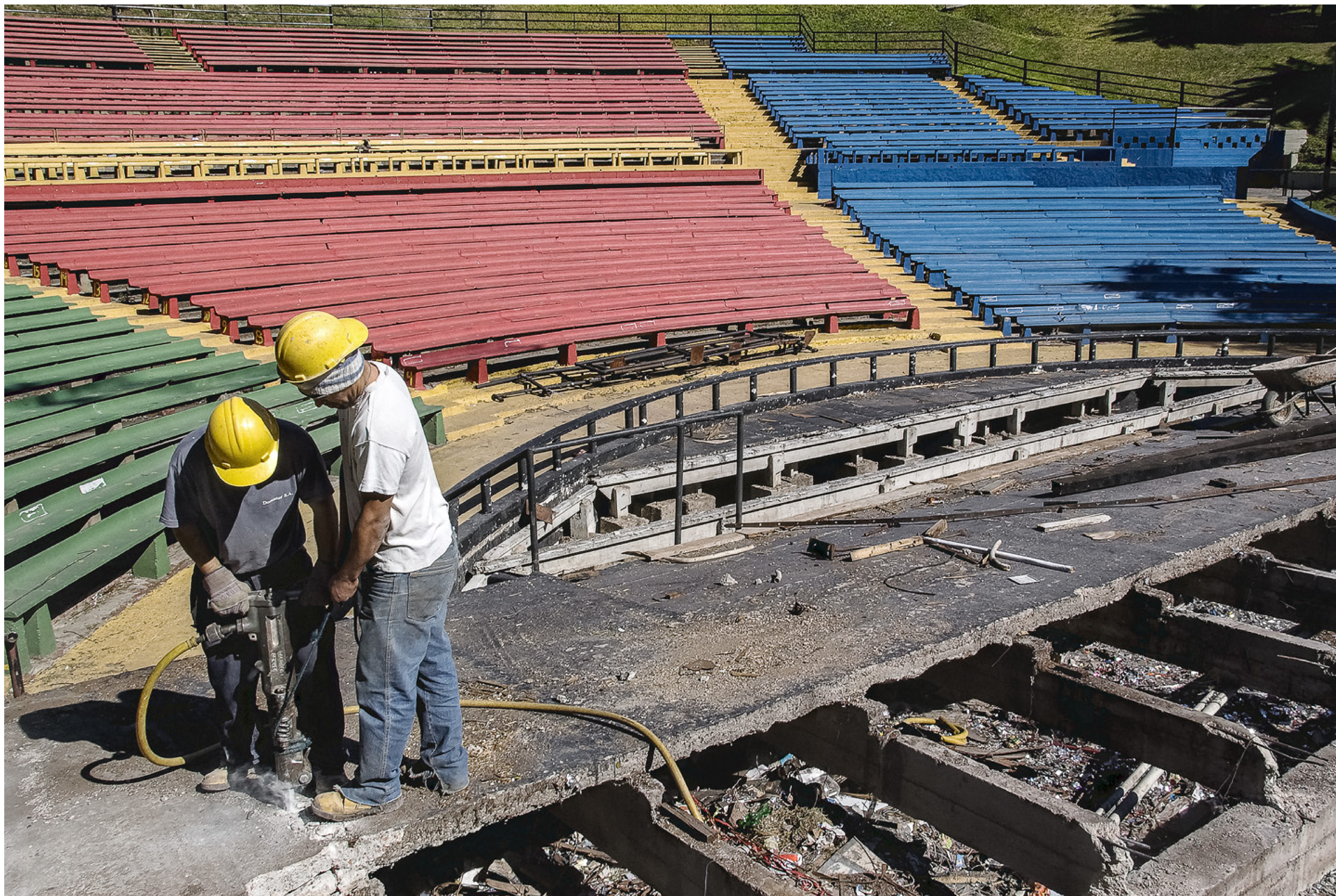
Retiro de las antiguas losas para la construcción del nuevo foso, bajo escenario y escenario. Teatro de Verano. 6 de setiembre de 2006. (Foto: 20087FMCMA.CDFIMO.UY – Autor: Carlos Contrera / Centro de Fotografía – Intendencia de Montevideo).
