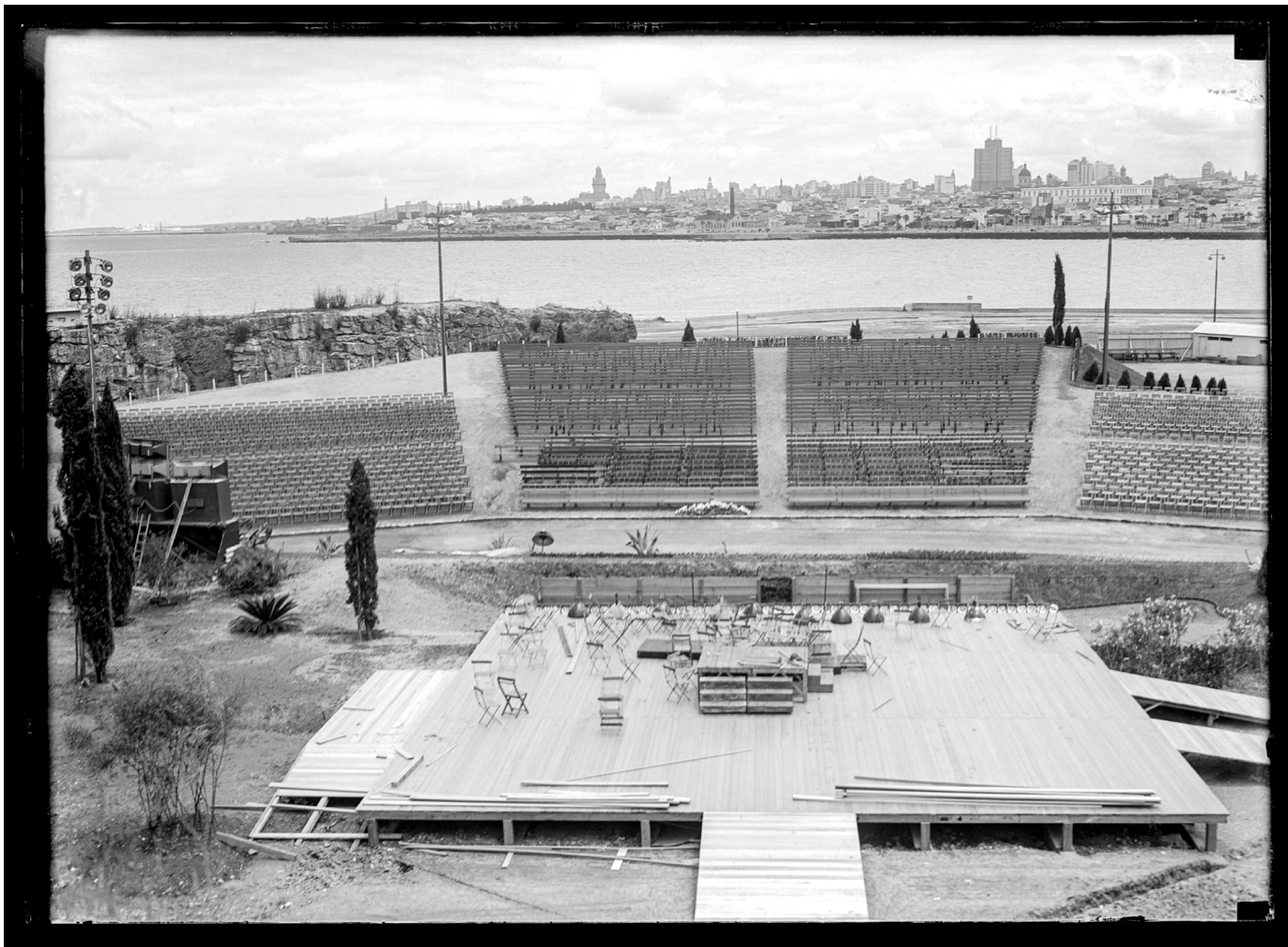
Construcción del Teatro de Verano. Año 1943.
