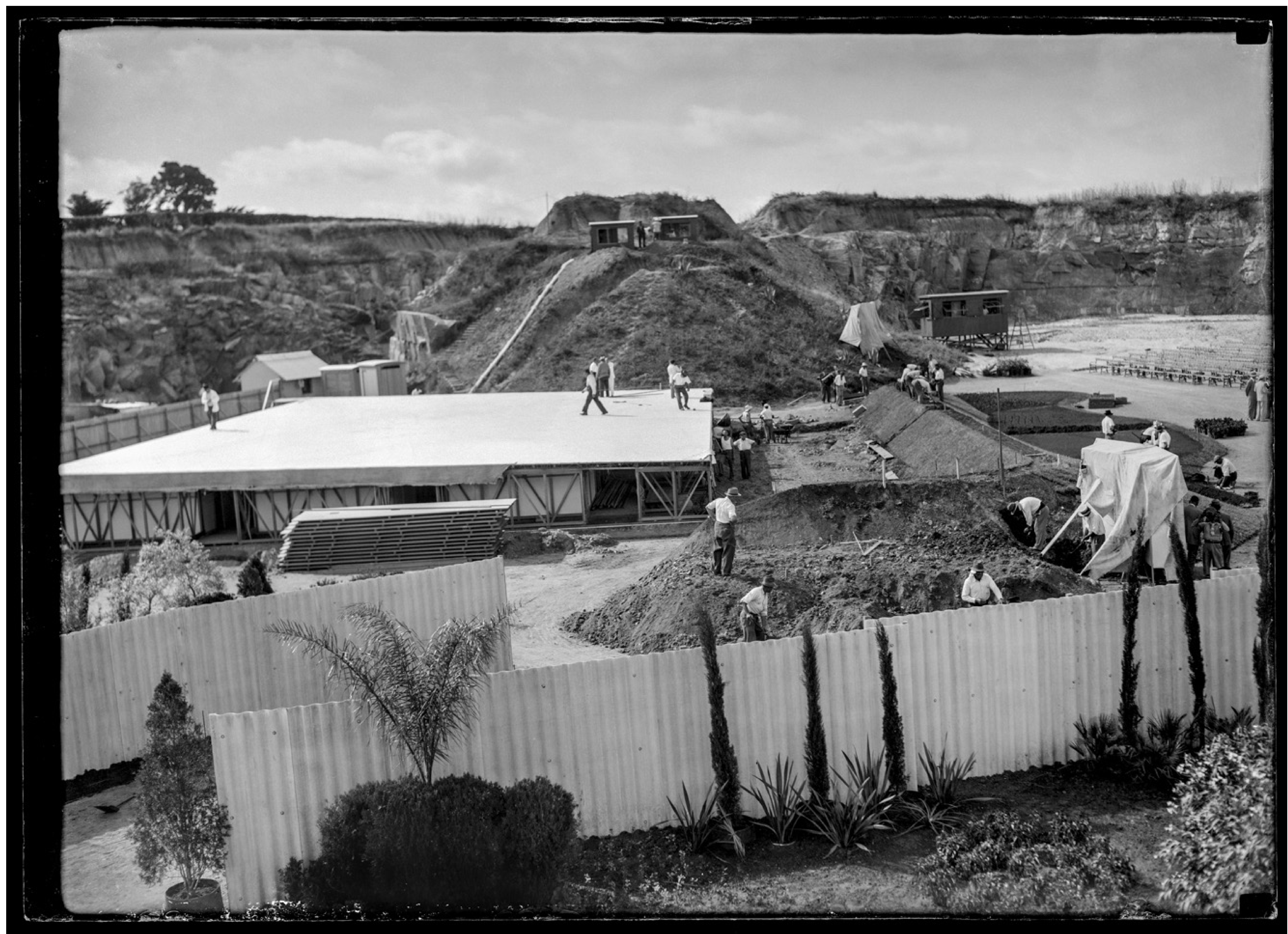
Construcción del Teatro de Verano. Año 1943.
