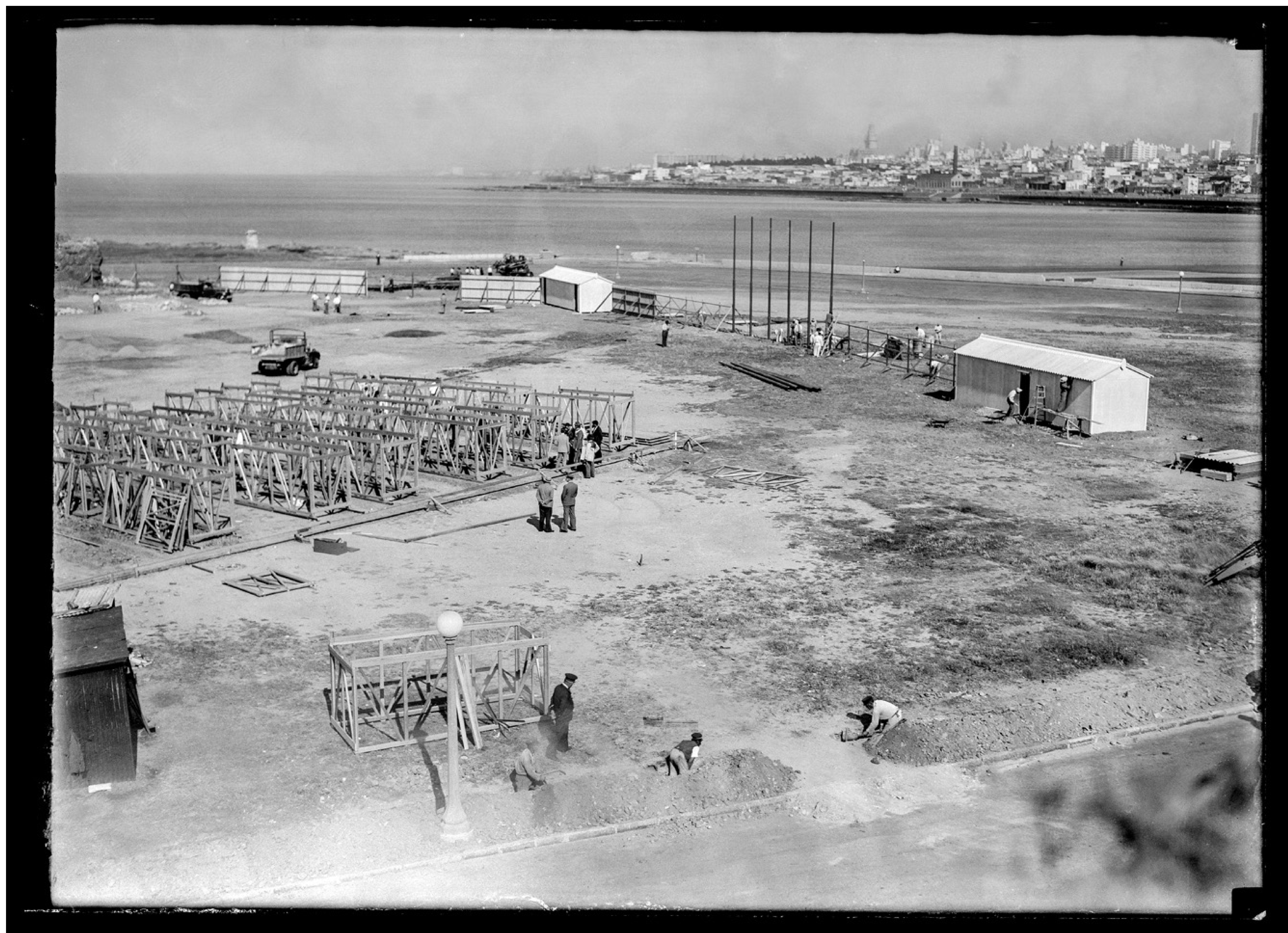
Construcción del Teatro de Verano. Año 1943.
