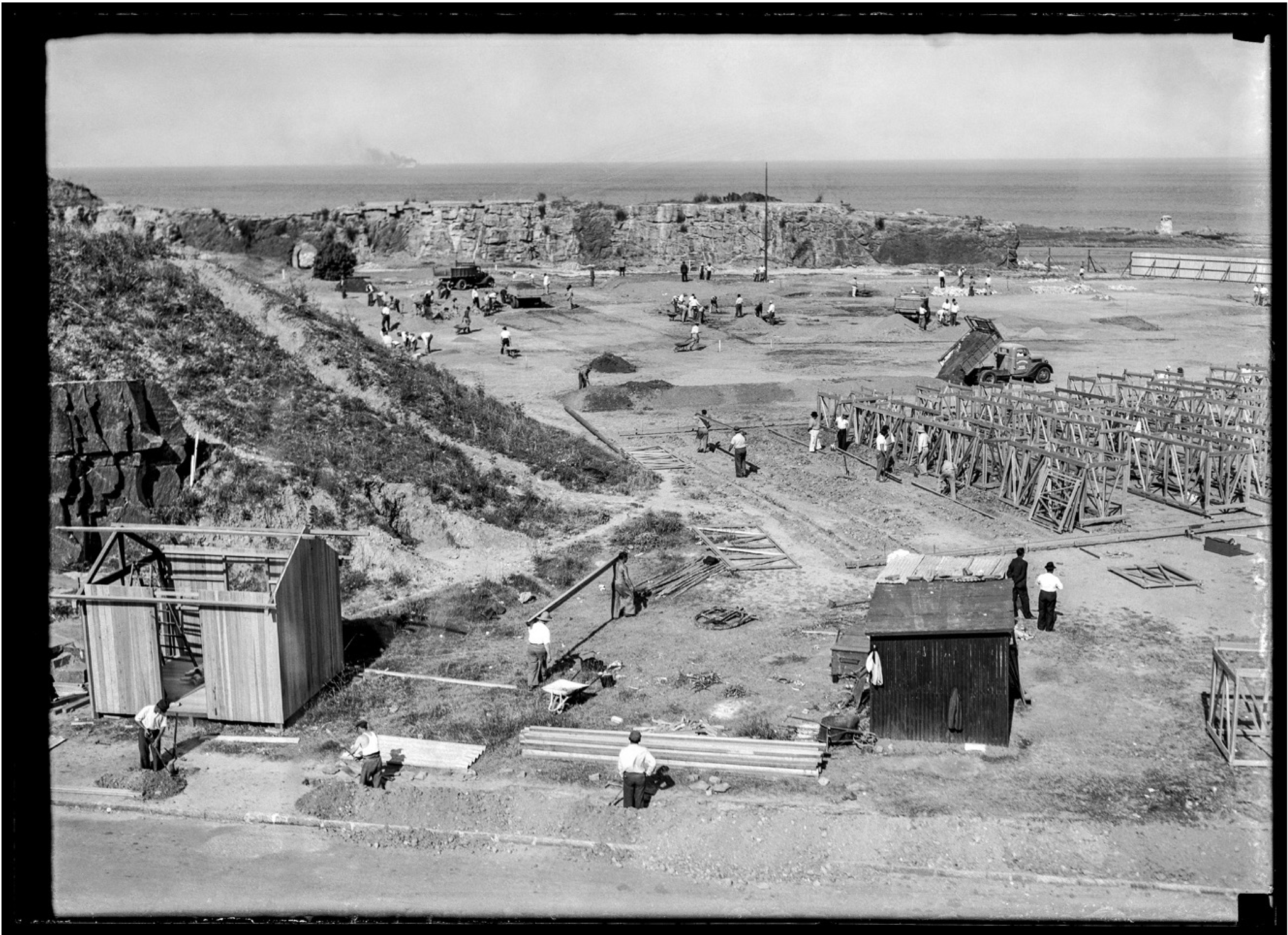
Construcción del Teatro de Verano. Año 1943.
