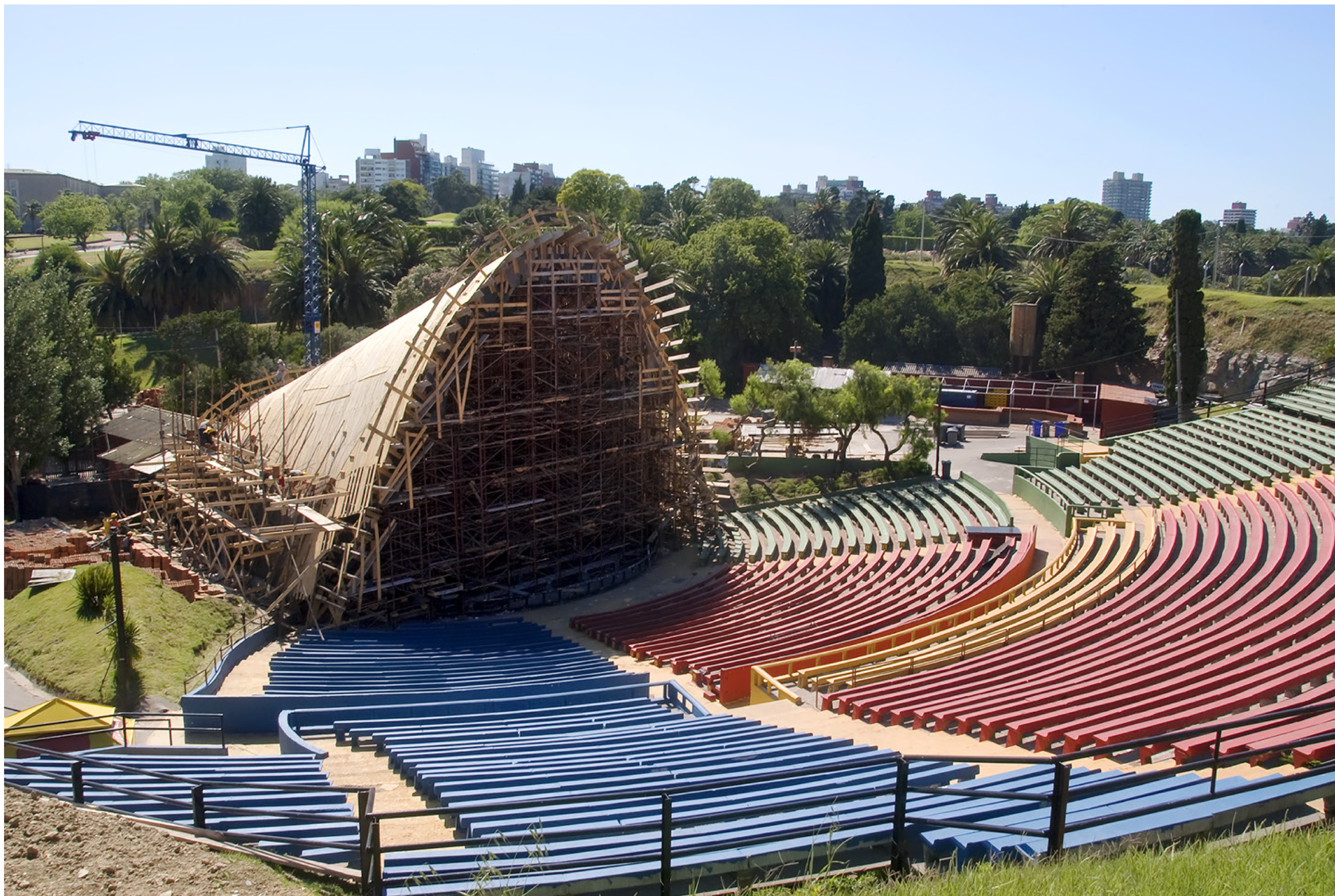
Vista desde el ingreso superior de platea alta de la nueva bóveda. Teatro de Verano. 30 de noviembre de 2006. (Foto: 20048FMCMA.CDFIMO.UY – Autor: Carlos Contrera / Centro de Fotografía – Intendencia de Montevideo).
