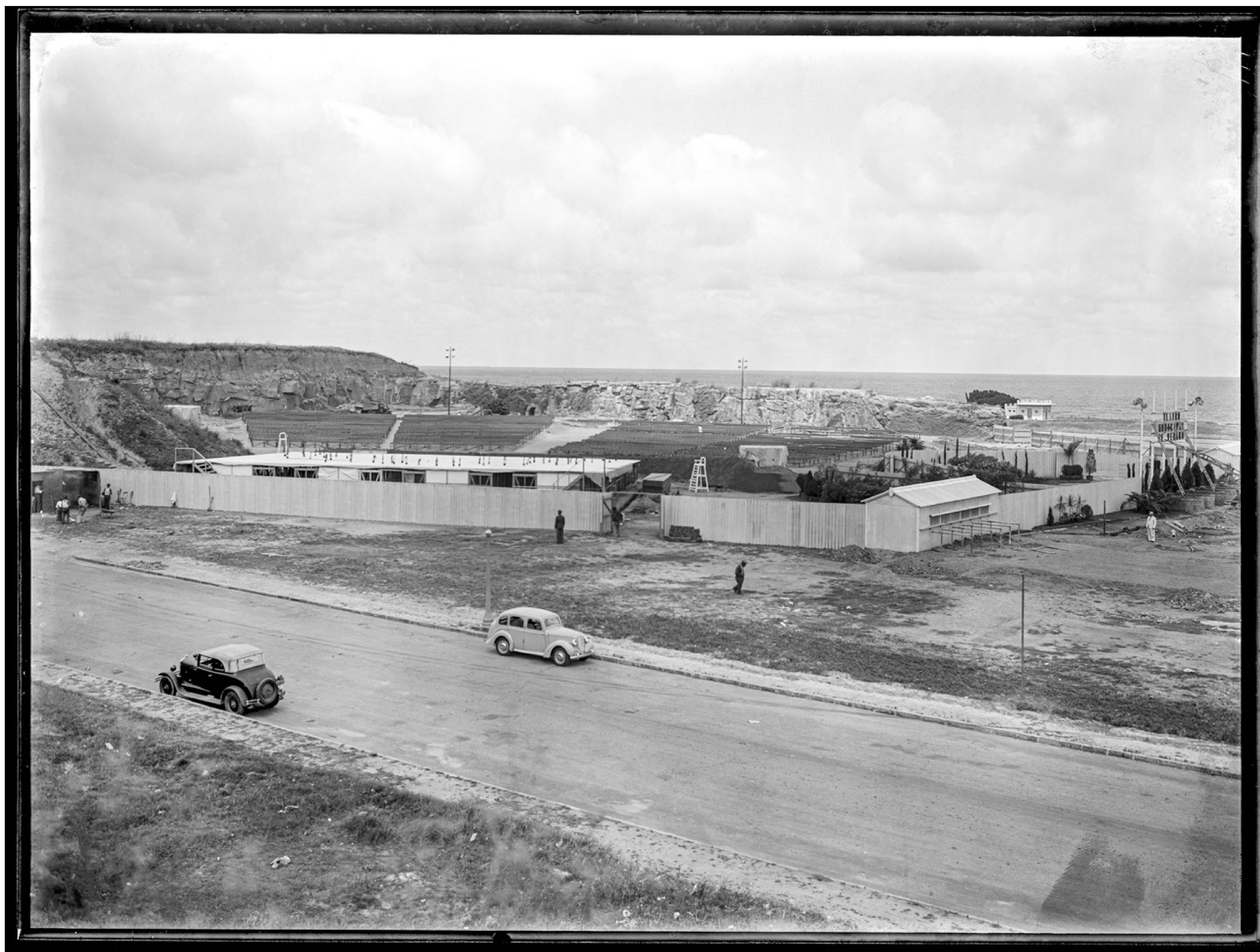
Construcción del Teatro de Verano. Año 1943.
