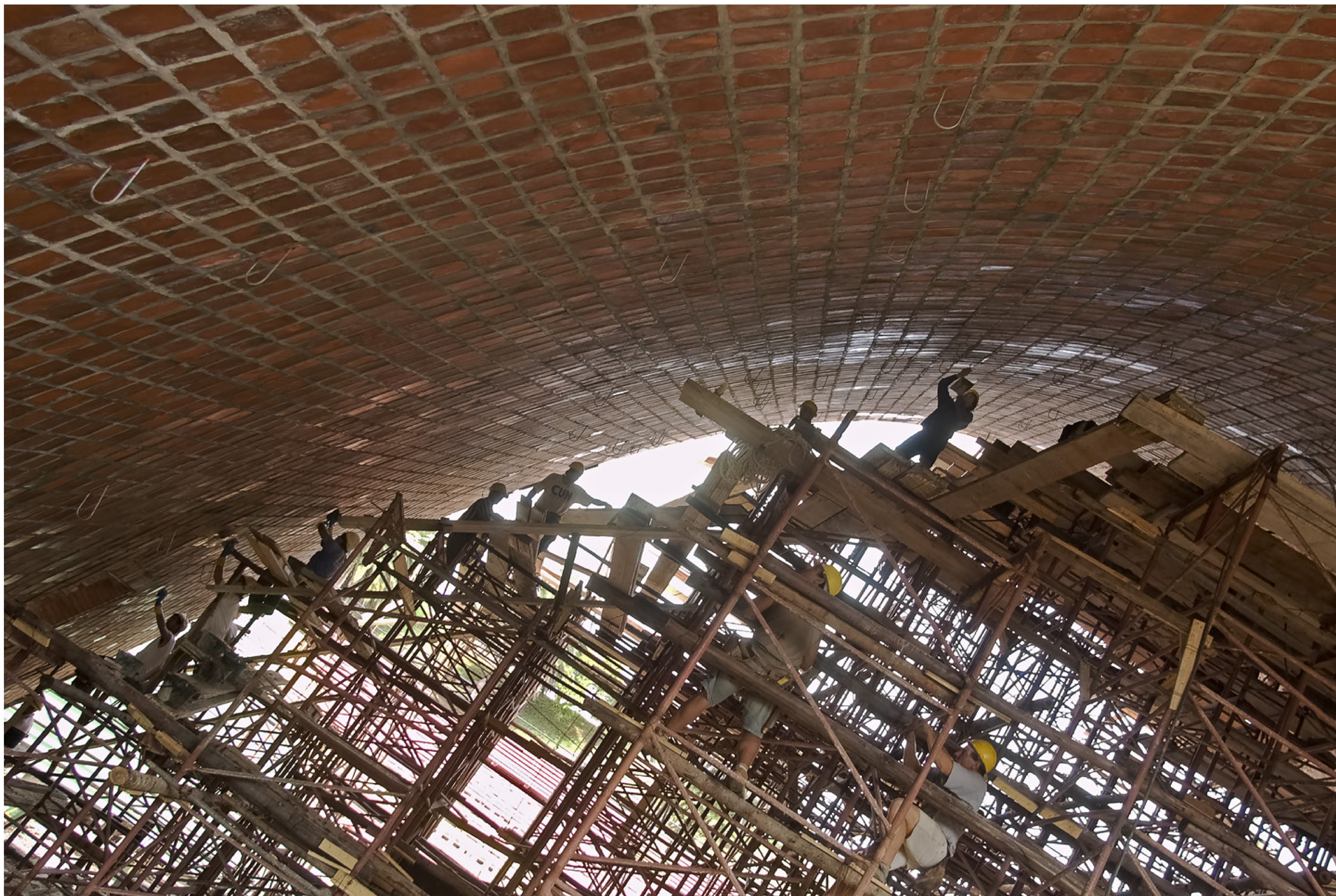
Trabajos de finalización de la construcción interior de la bóveda del Teatro de Verano. 19 de diciembre de 2006. (Foto: 20073FMCMA.CDFIMO.UY – Autor: Carlos Contrera / Centro de Fotografía – Intendencia de Montevideo).
