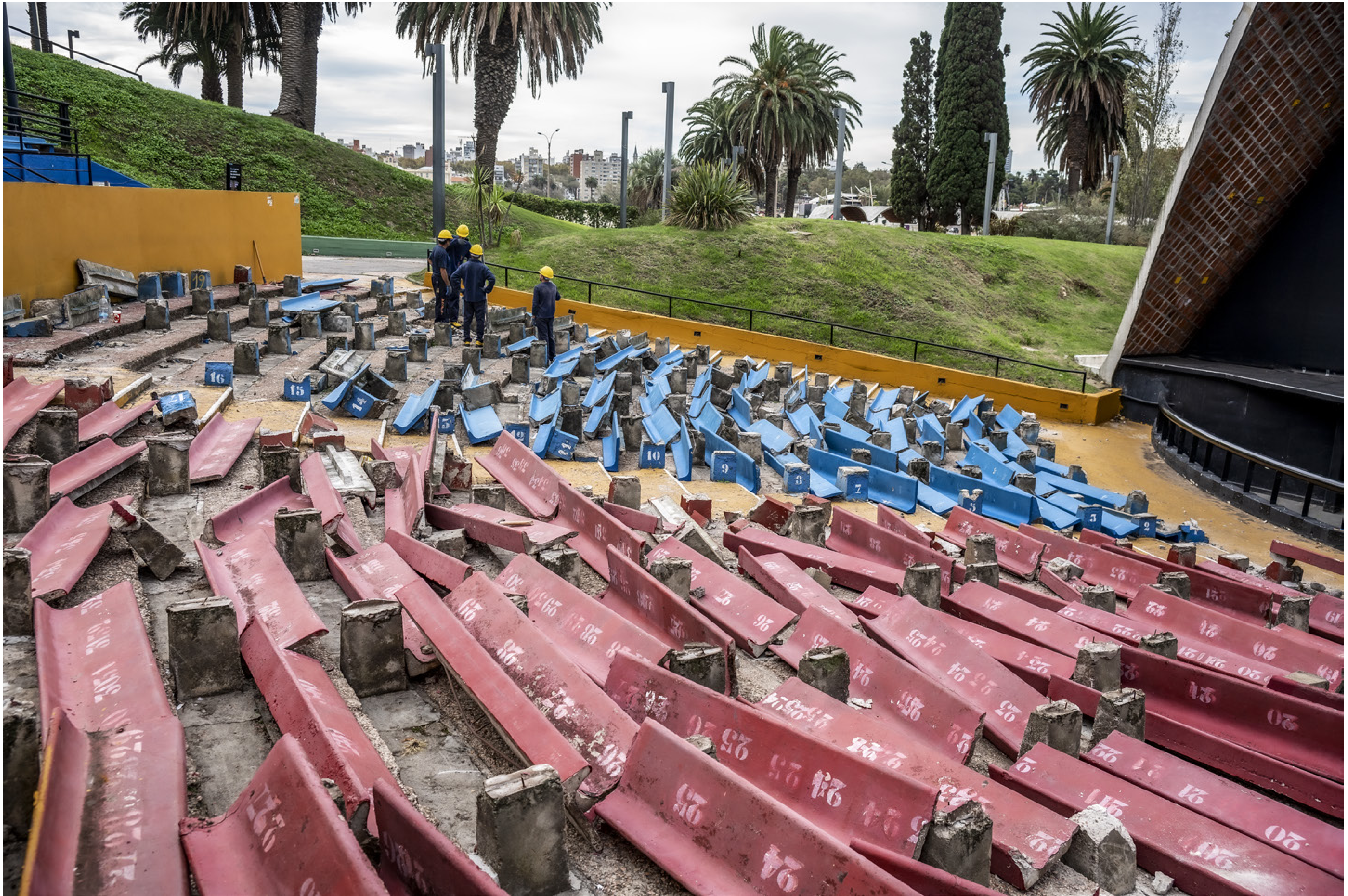
Desmantelamiento de bancos de platea baja. Teatro de Verano. 9 de mayo de 2023. (Foto: 94690FMCMA.CDFIMO.UY – Autora: Lucía Martí / Centro de Fotografía – Intendencia de Montevideo).
