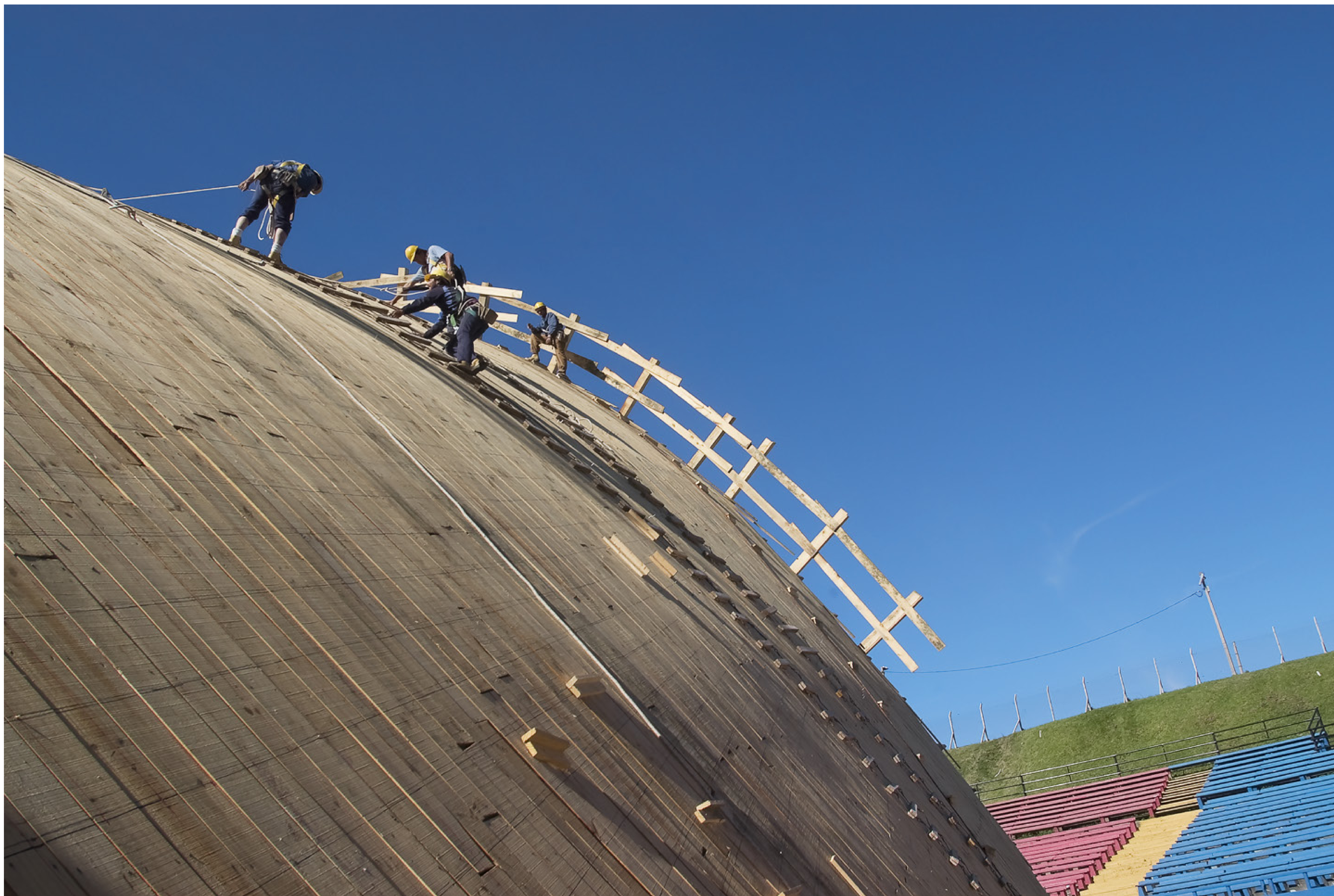
Finalización del encofrado para la construcción de la nueva bóveda. Teatro de Verano. 22 de noviembre de 2011. (Foto: 20040FMCMA.CDFIMO.UY – Autor: Carlos Contrera / Centro de Fotografía – Intendencia de Montevideo).
