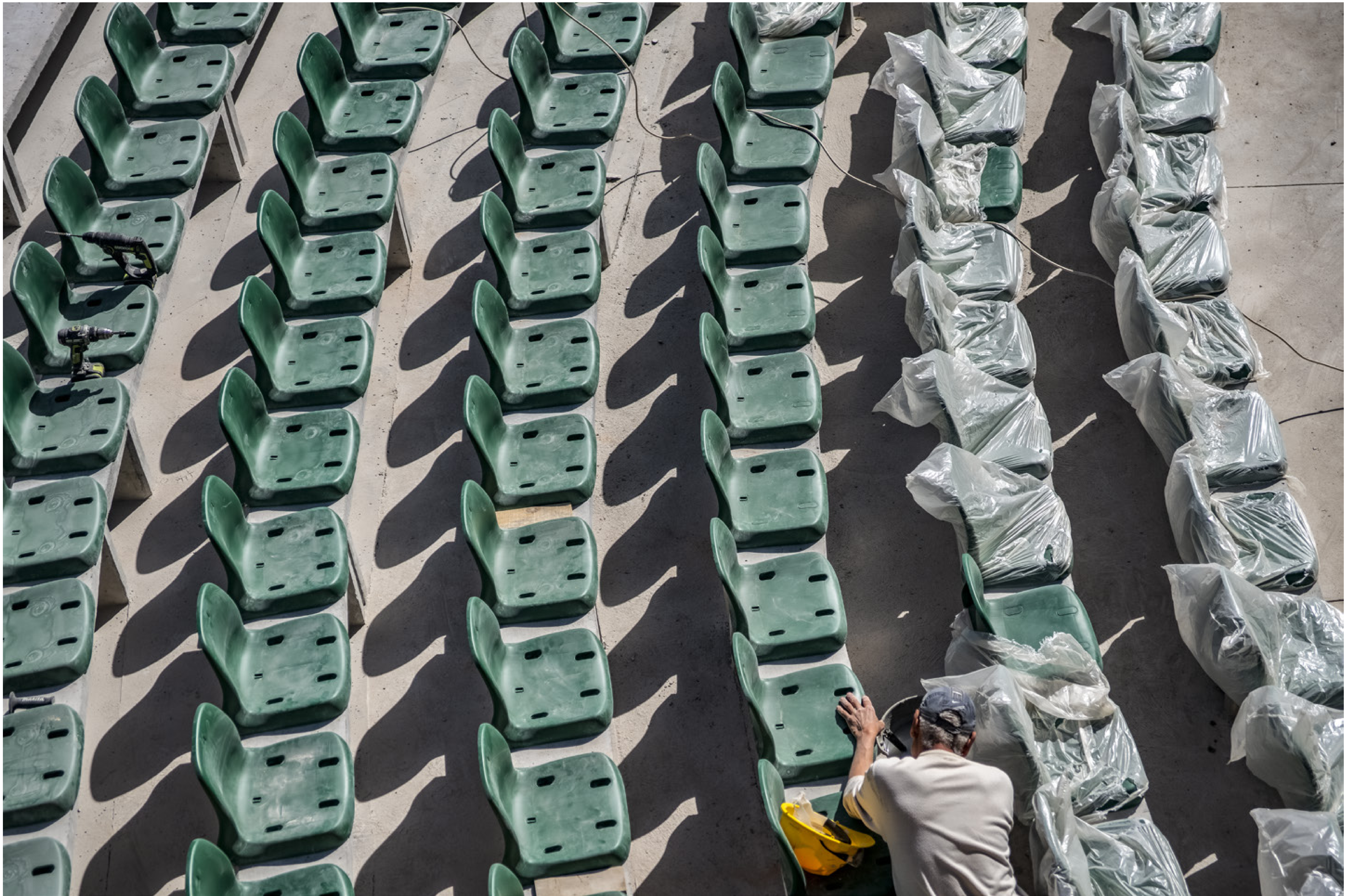
Instalación de nuevas butacas en platea baja. Teatro de Verano. 13 de setiembre de 2023. (Foto: 96836FMCMA.CDFIMO.UY – Autora: Lucía Martí / Centro de Fotografía – Intendencia de Montevideo).
