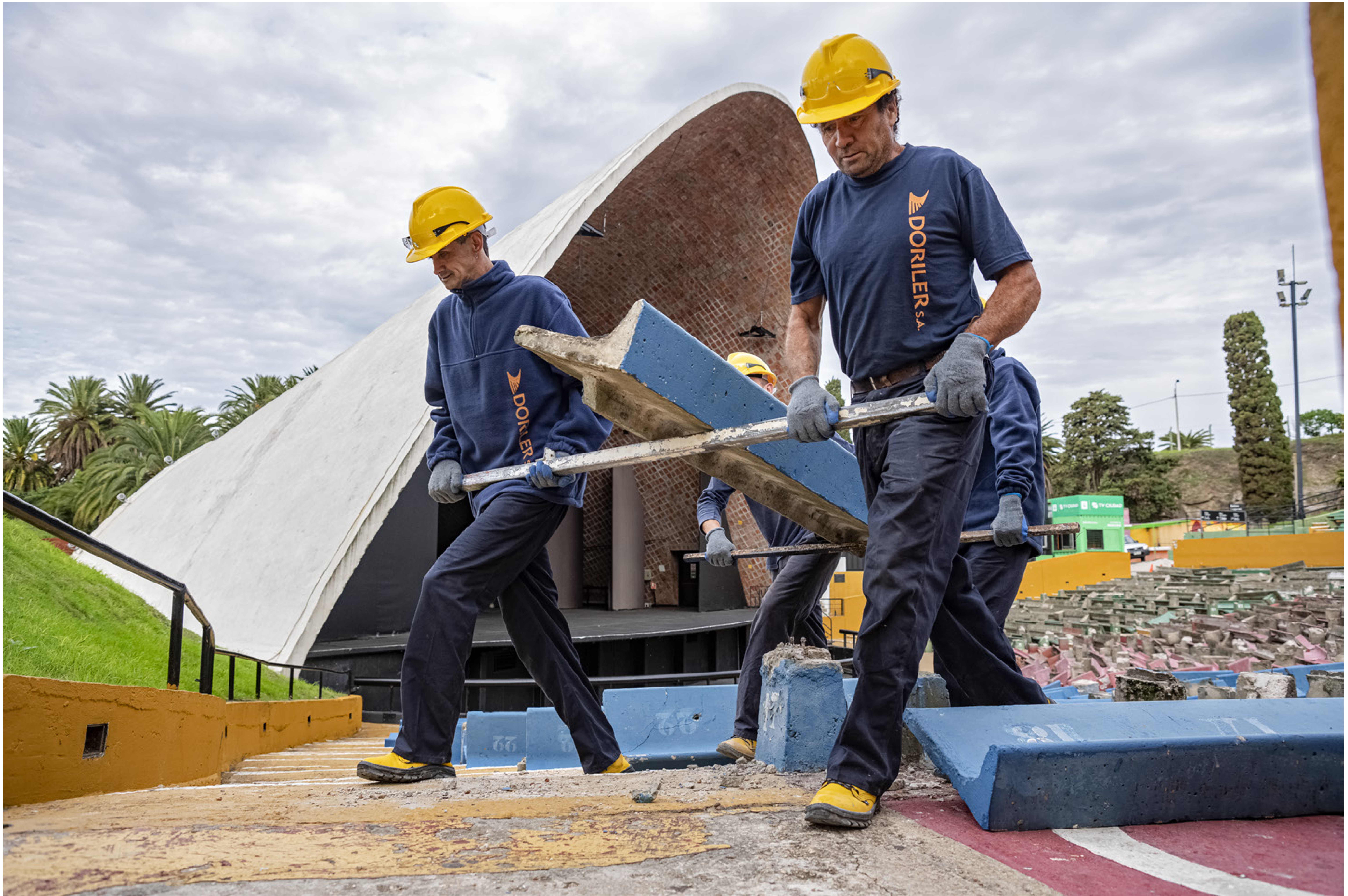
Desmantelamiento de bancos de platea baja. Teatro de Verano. 9 de mayo de 2023. (Foto: 94681FMCMA.CDFIMO.UY – Autora: Lucía Martí / Centro de Fotografía – Intendencia de Montevideo).
