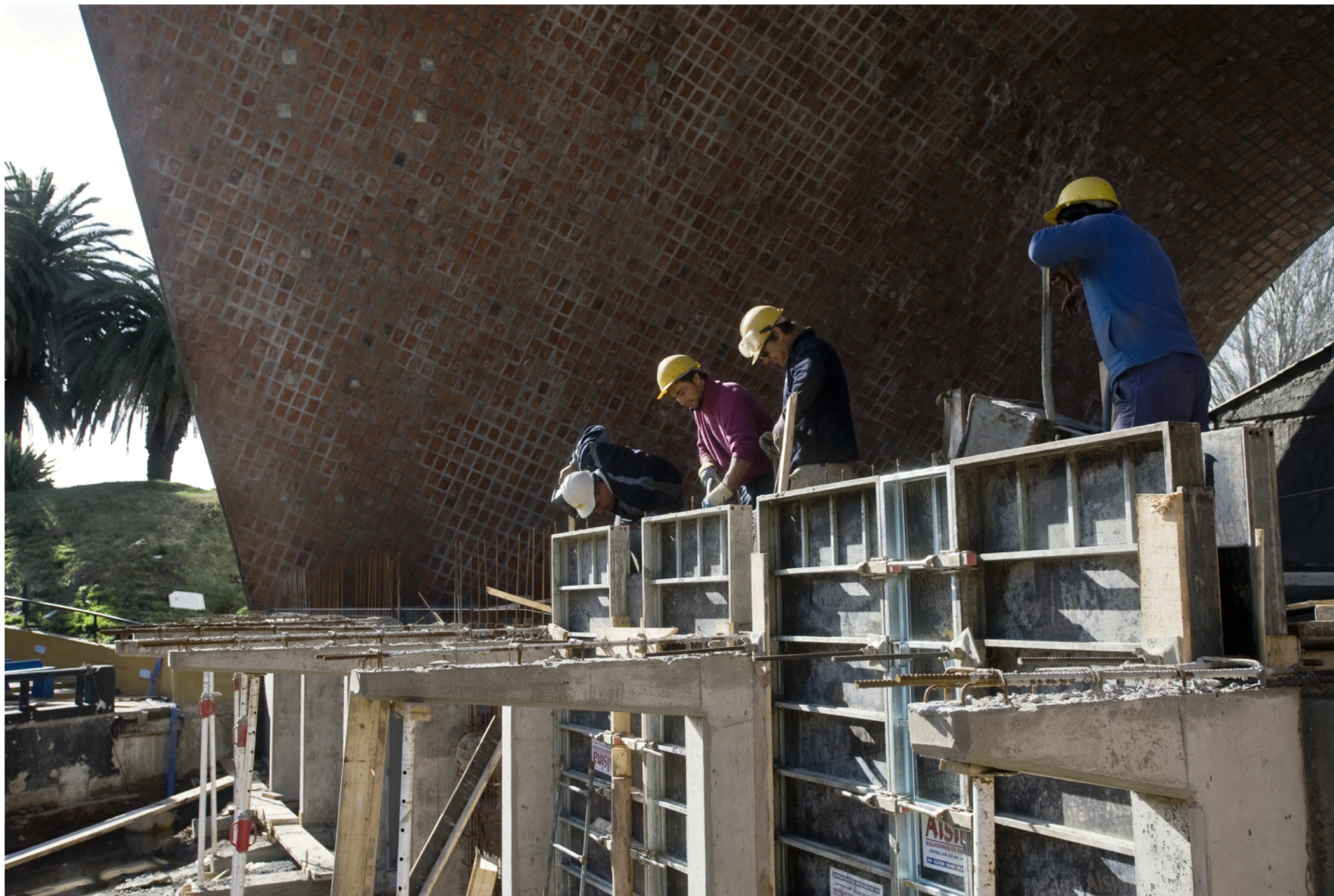
Proceso de construcción del muro frontal del bajo escenario y estructuras del proscenio. Teatro de Verano. 3 de setiembre de 2009. (Foto: 17715FMCMA.CDFIMO.UY – Autor: Carlos Contrera / Centro de Fotografía – Intendencia de Montevideo).
