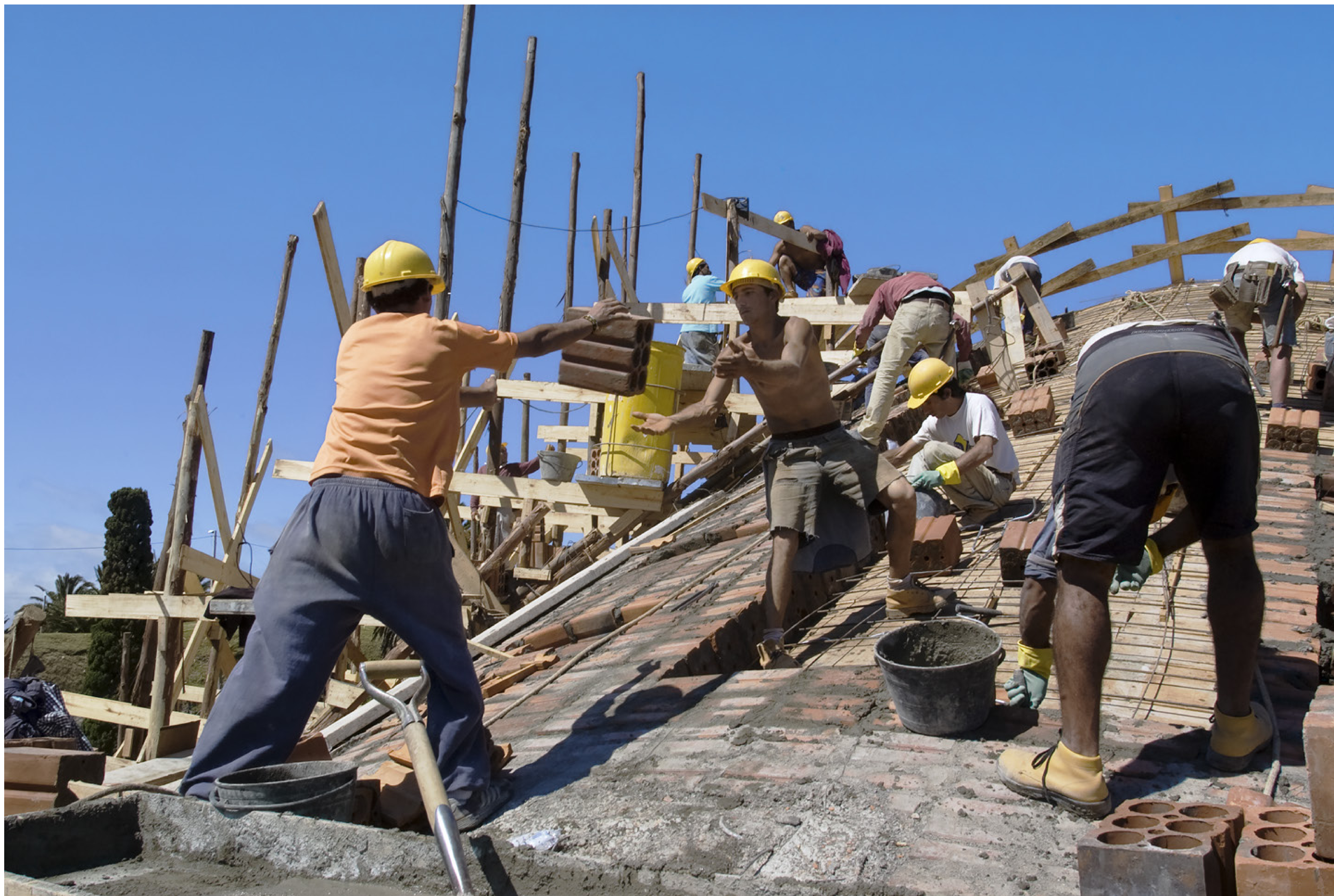
Construcción de la bóveda desarrollada con la ingeniería de cerámica armada de Eladio Dieste. Teatro de Verano. 6 de diciembre de 2006. (Foto: 20068FMCMA.CDFIMO.UY – Autor: Carlos Contrera / Centro de Fotografía – Intendencia de Montevideo).
