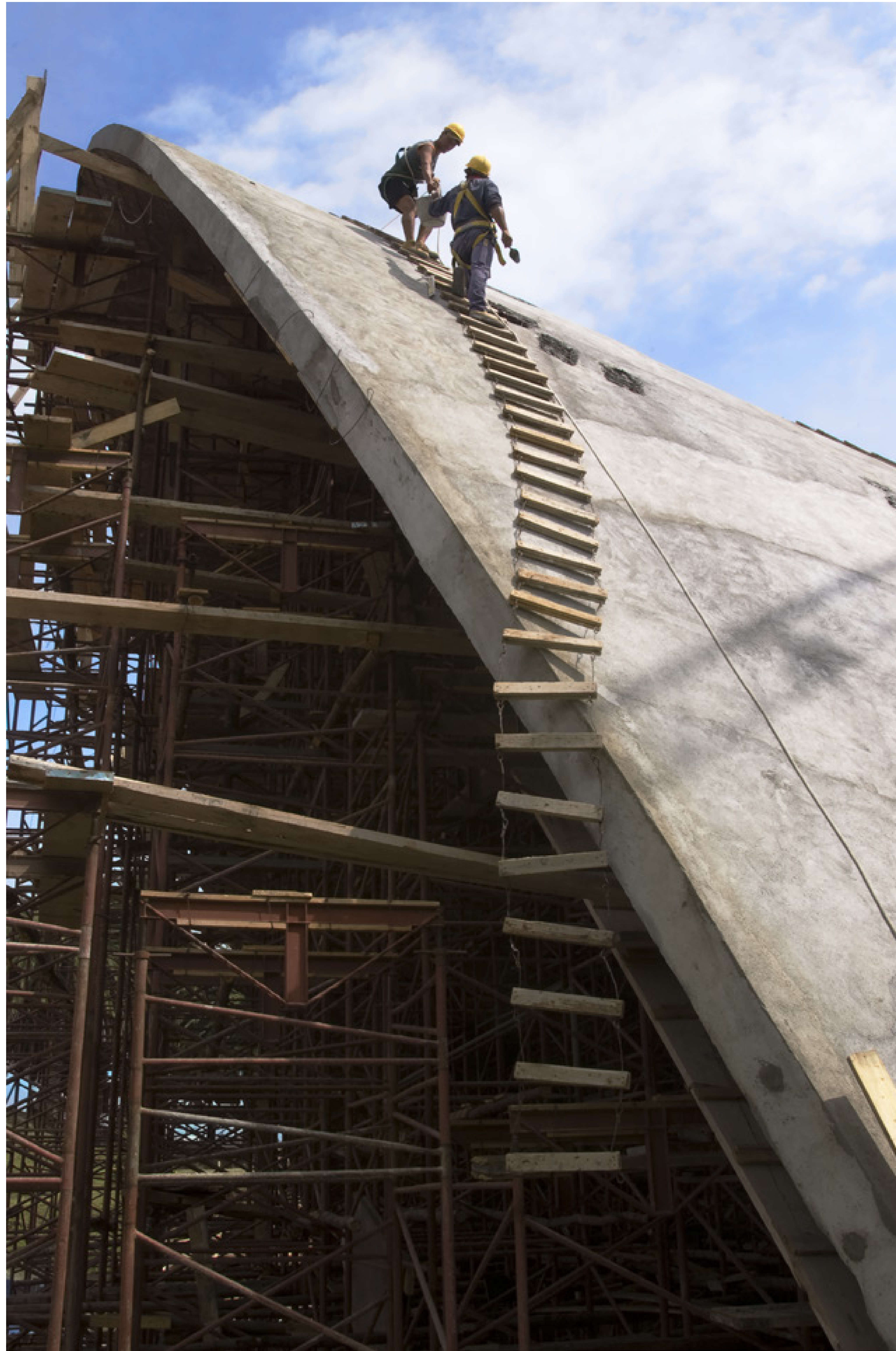
Construcción de la bóveda desarrollada con la ingeniería de cerámica armada de Eladio Dieste. Teatro de Verano. 19 de diciembre de 2006. (Foto: 20078FMCMA.CDFIMO.UY – Autor: Carlos Contrera / Centro de Fotografía – Intendencia de Montevideo).
