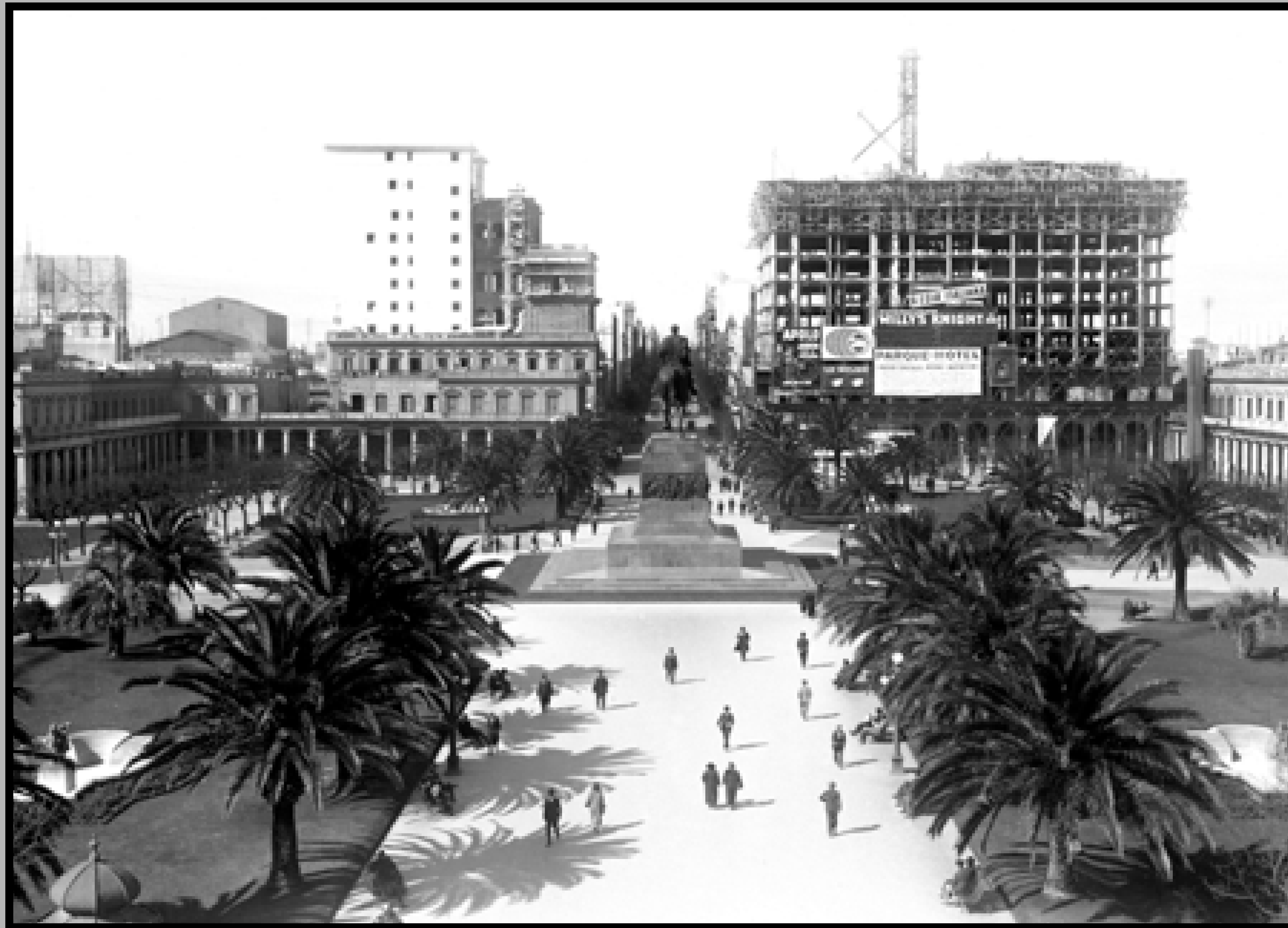
Palacio Salvo en construcción. Adelante: Plaza Independencia. Años 1924 - 1925 (aprox.). (Foto: 03714FMHGE.CDFIMO.UY - Autor: S.d./IMO).
