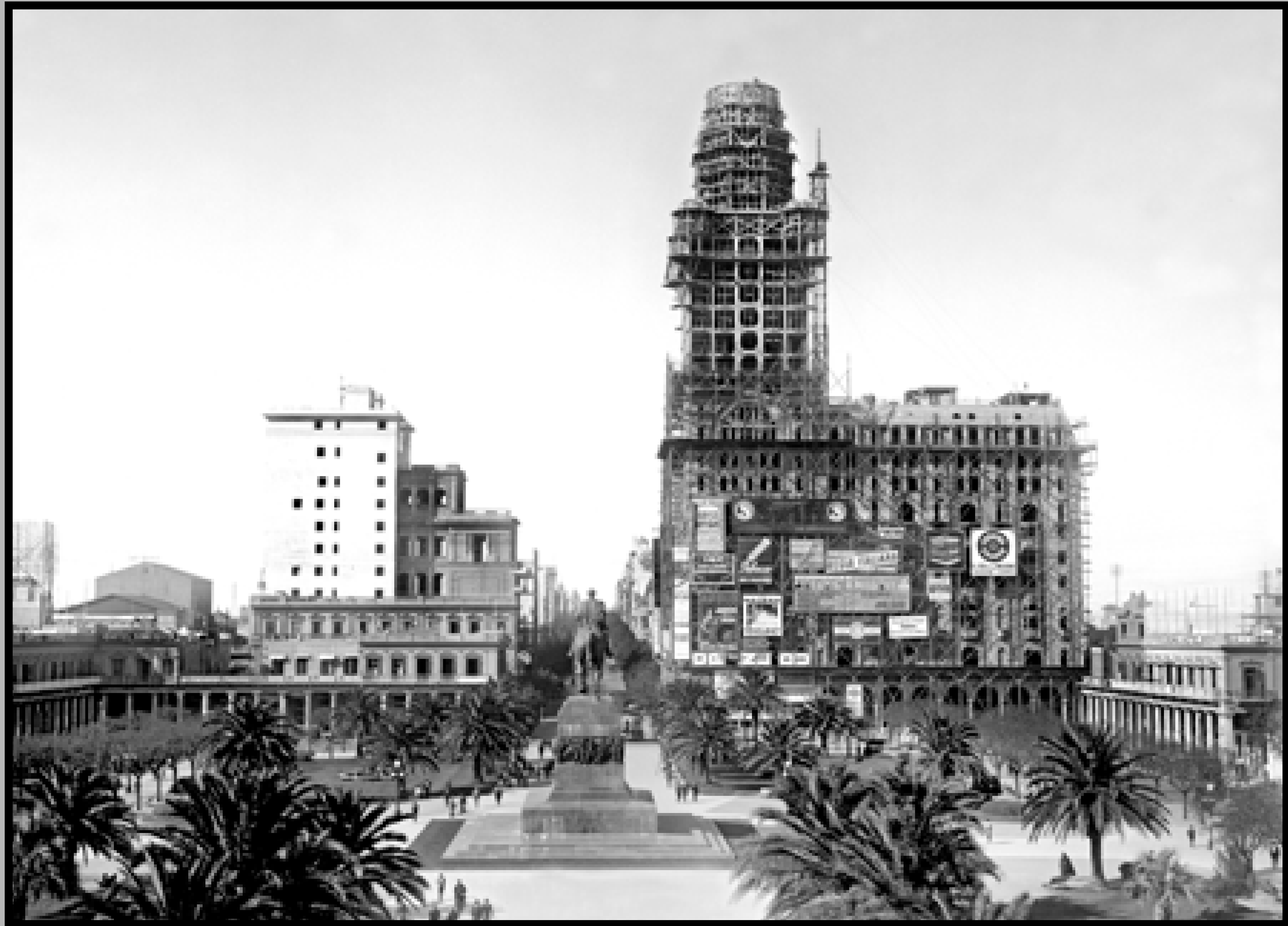
Palacio Salvo en construcción. Adelante: Plaza Independencia. Años 1926 - 1927 (aprox.). (Foto: 03940FMHGE.CDFIMO.UY - Autor: S.d./IMO).
