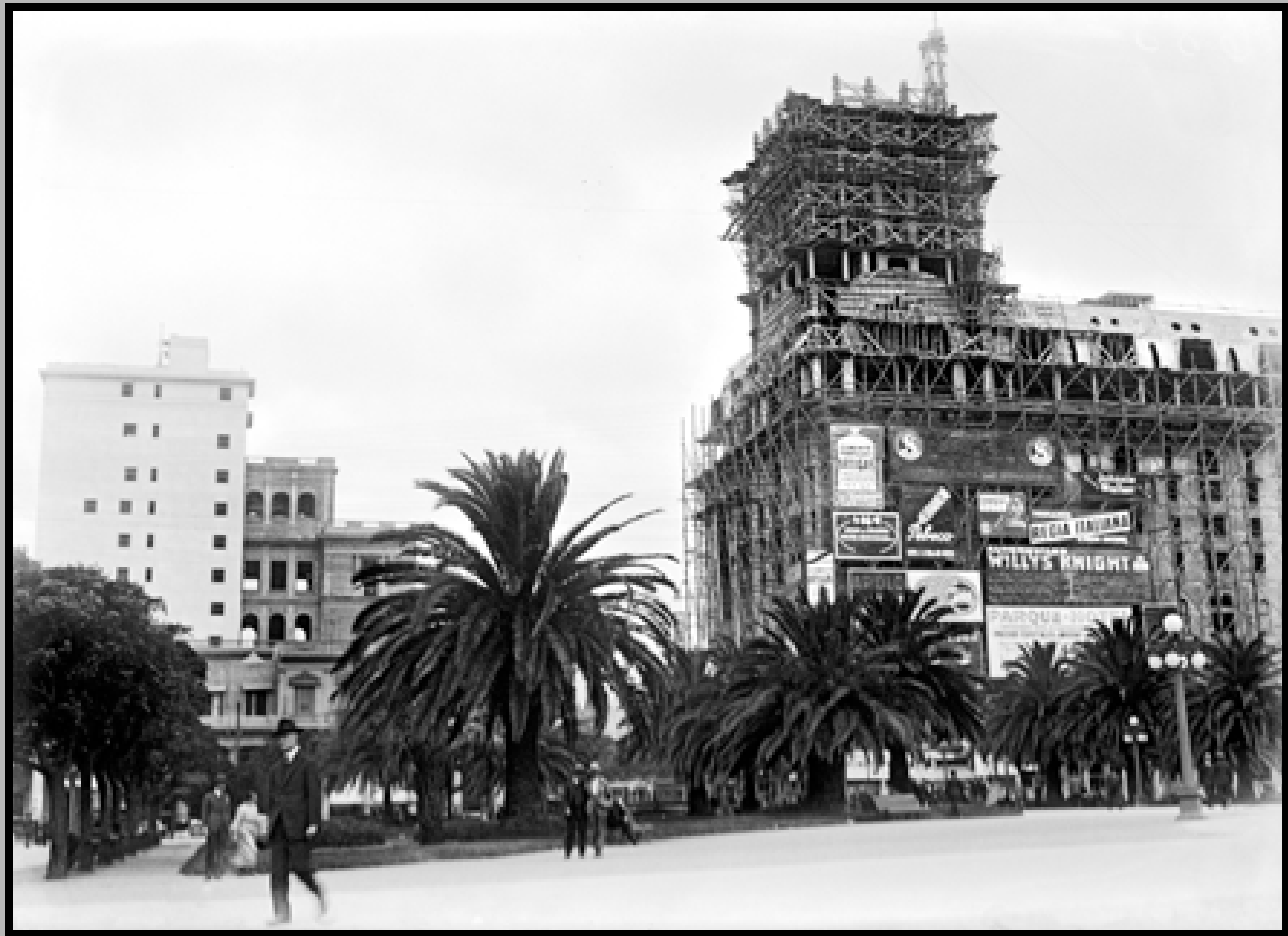
Palacio Salvo en construcción. Adelante: Plaza Independencia. Años 1923-1928 (aprox.). (Foto: 0683FMHB.CDF.IMO.UY - Autor: S.d./IM).
