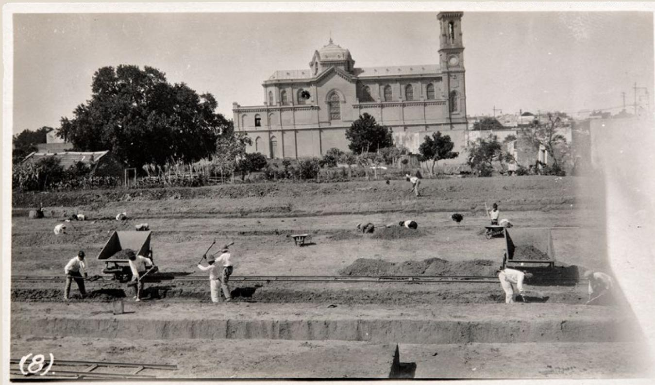
Preparación del terreno para las franjas de cimentación. Al fondo se aprecia la
