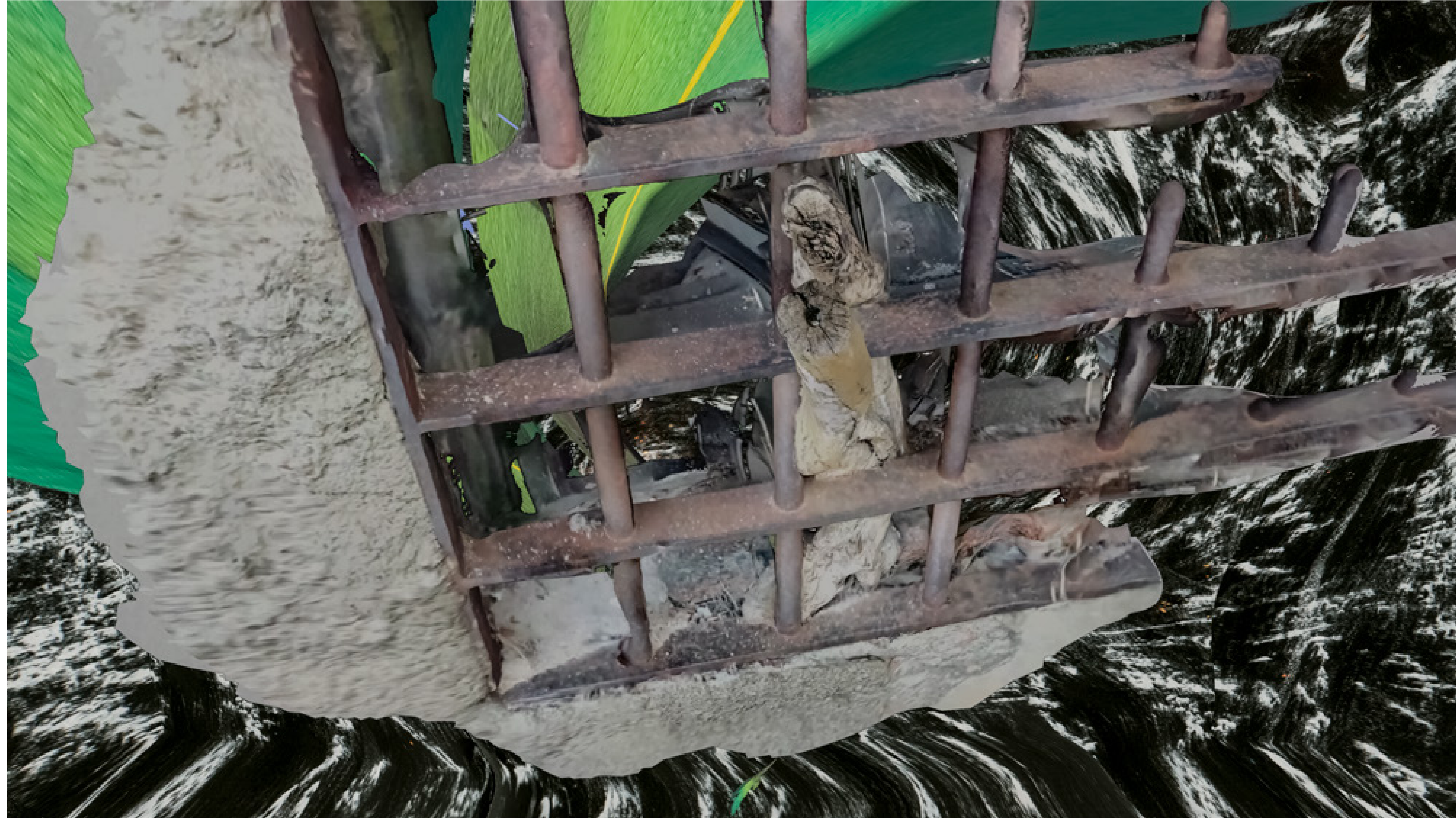
Registro: Reja de la explanada norte + contactografía realizada en el recorrido + grafiti en calle Estrella del Norte. Fotogrametría y fotografía digital procesadas en Resolume Arena.
