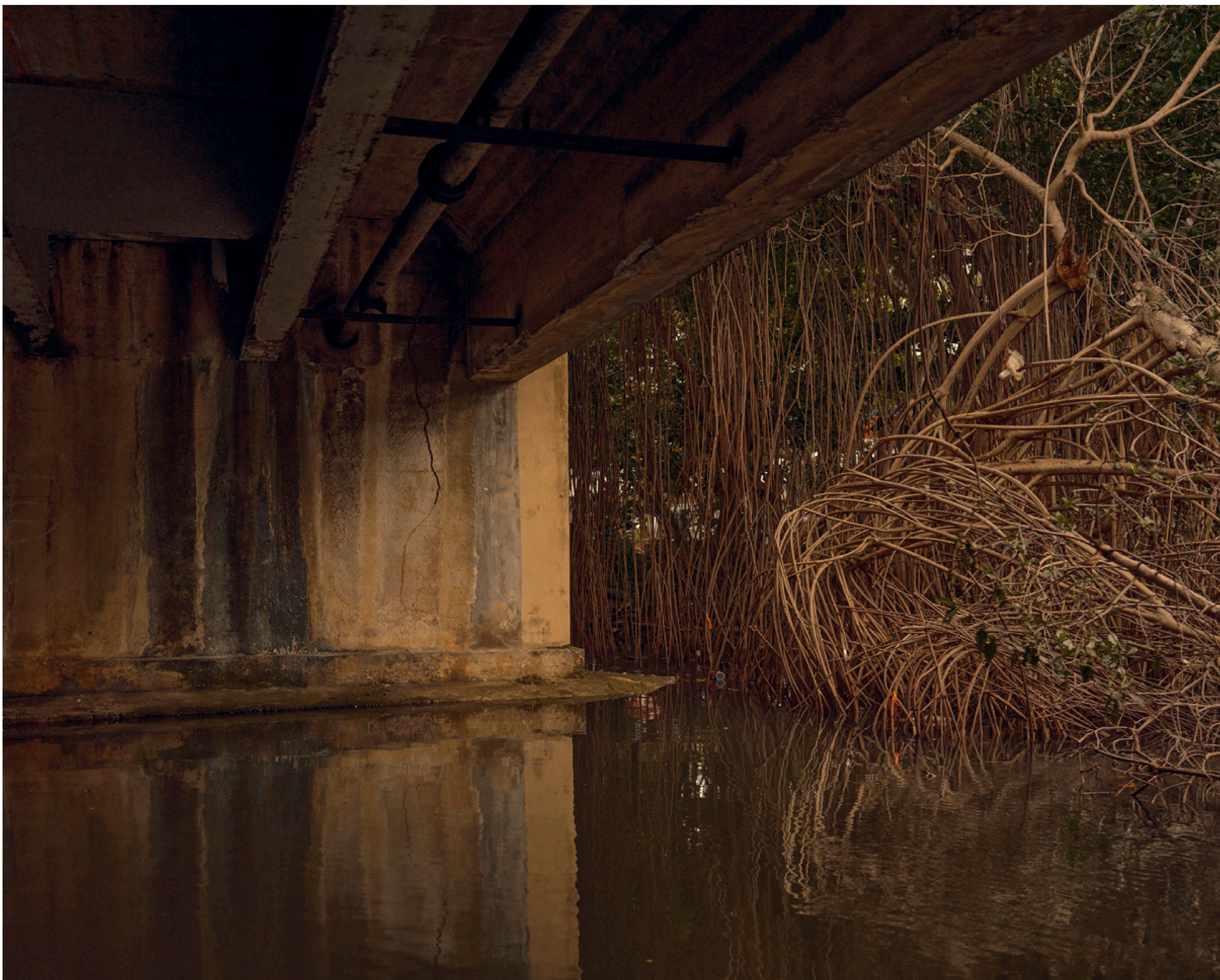
La arquitectura de la permanencia. Un puente sobre el canal, justo cuando se ensancha hacia el estuario de la bahía de San Juan. Esta zona fue dragada hace años y sirve de modelo de cómo lucirían las orillas del Caño una vez restauradas. El Caño Martín Peña. San Juan, Puerto Rico. 2024. Fotografía digital. Christopher Gregory Rivera.
