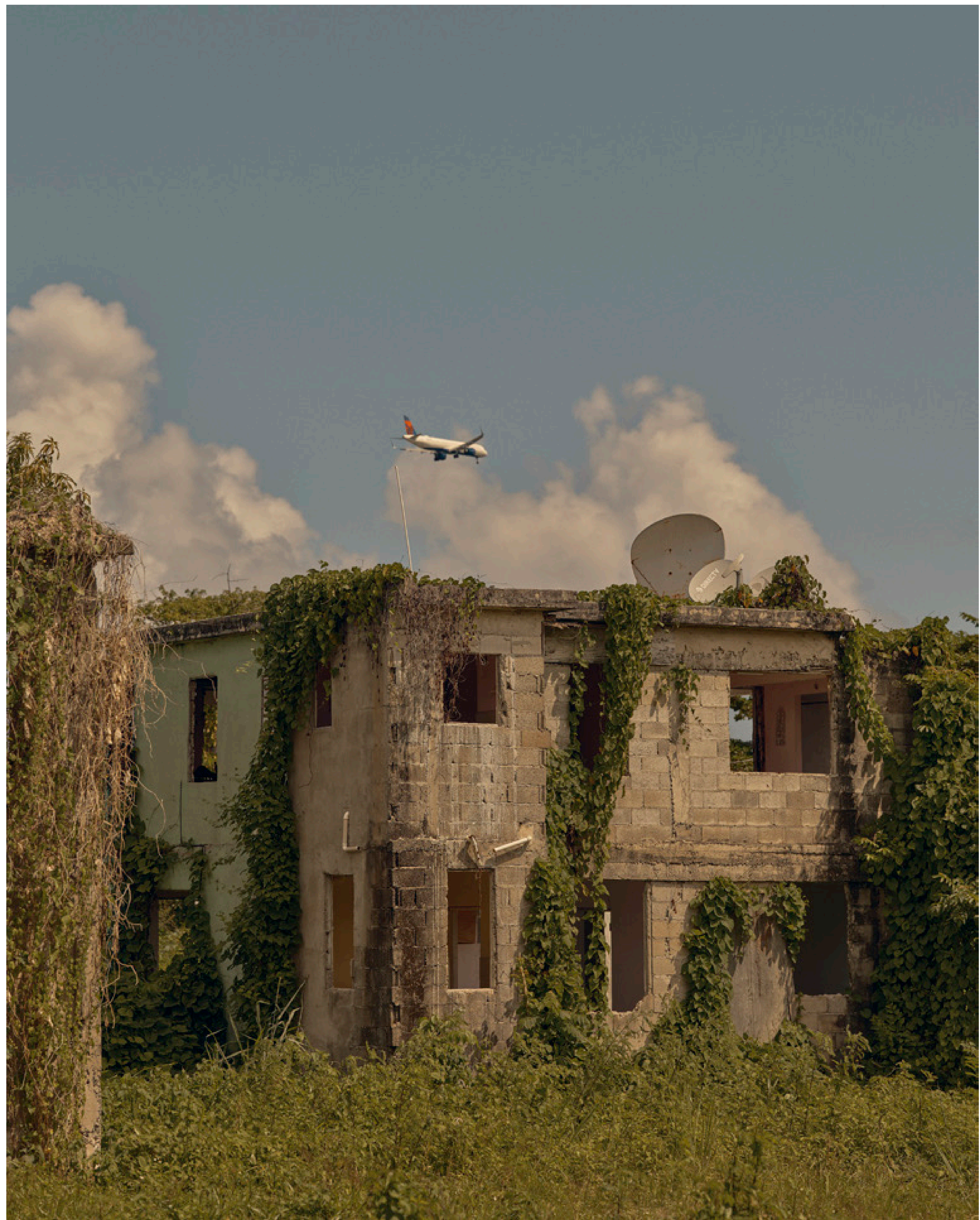
La arquitectura de la permanencia. Viviendas antiguas, a punto de ser demolidas, cerca de la orilla del canal en el barrio de Bitumul. El Caño Martín Peña. San Juan, Puerto Rico. 2024. Fotografía digital. Christopher Gregory Rivera.
