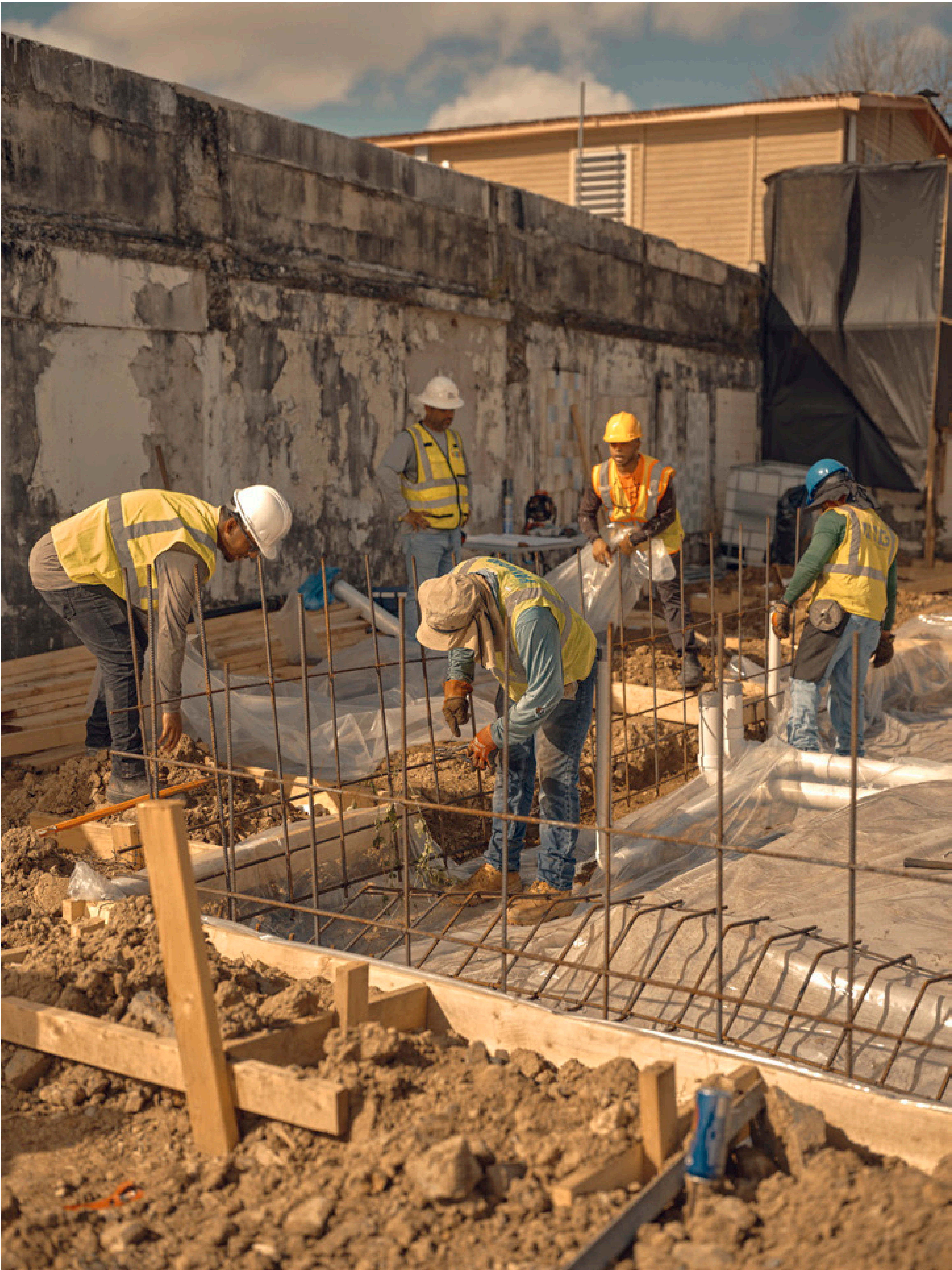
La arquitectura de la permanencia. Construcción de una de las nuevas casas que se destinarán a una familia reubicada, probablemente desde las orillas del canal. El Caño Martín Peña. San Juan, Puerto Rico. 2024. Fotografía digital. Christopher Gregory Rivera.
