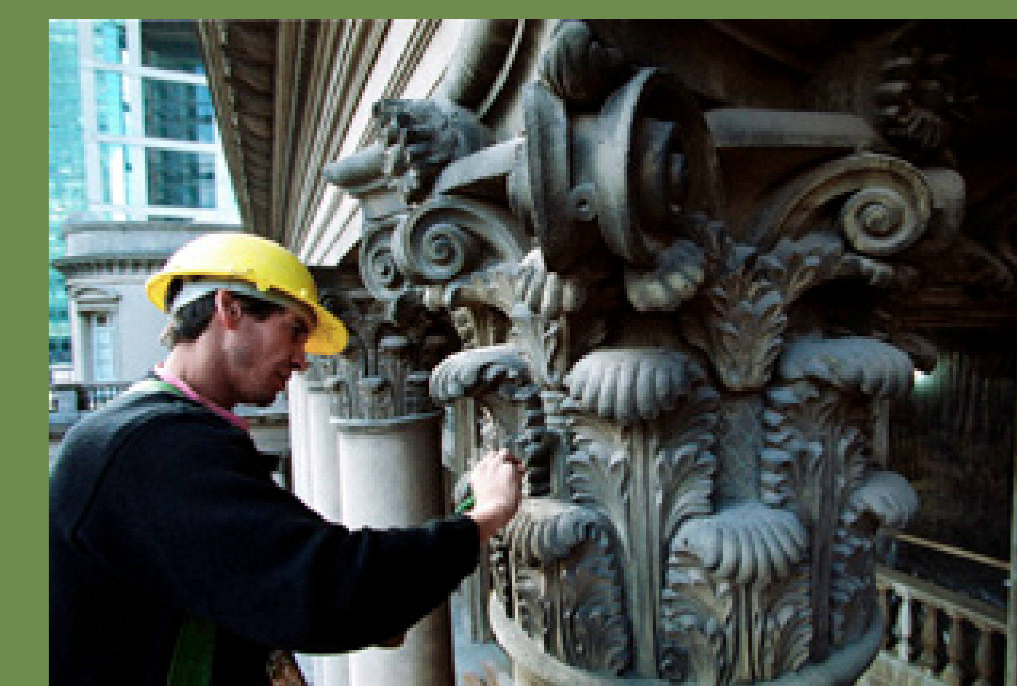
Restauración del Teatro Solís. Mayo de 2004. (Foto: 0083H.CDF.IMO.UY - Autor: Carlos Contrera/CdF)
