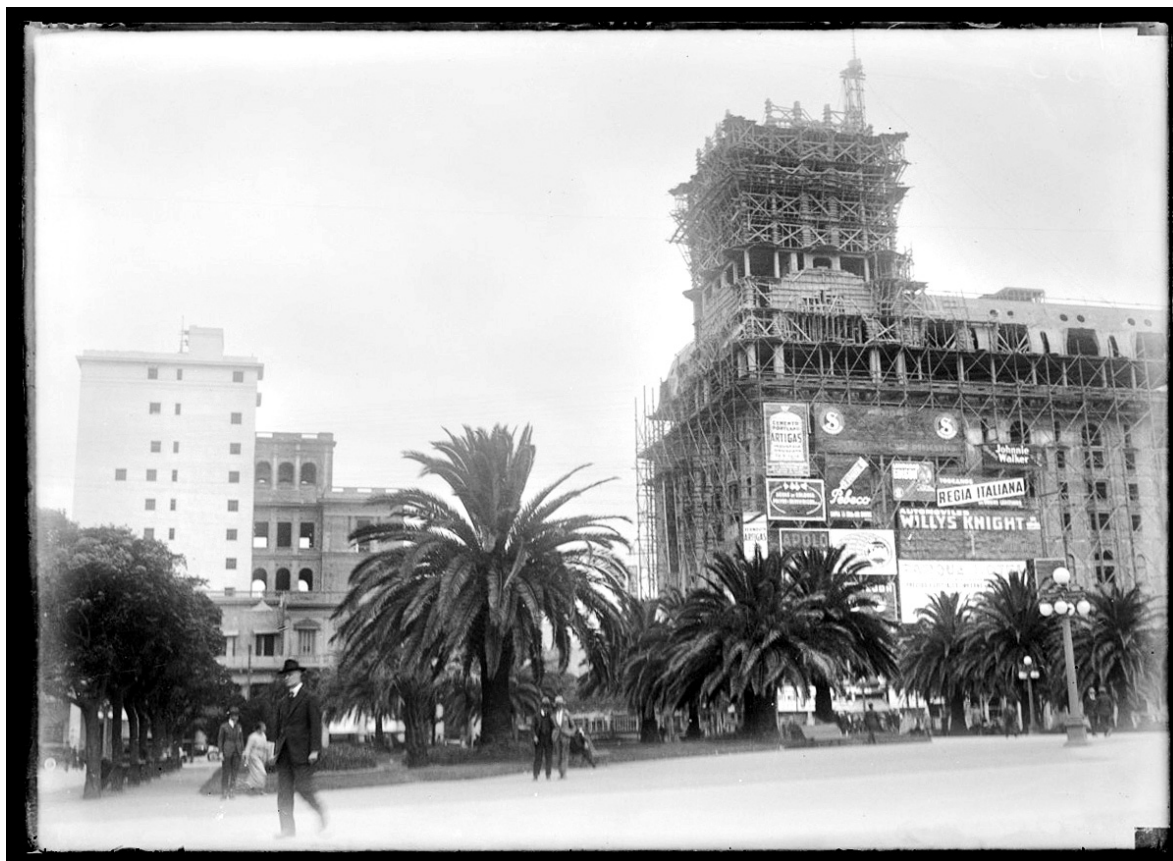
Construcción del Palacio Salvo vista desde la Plaza Independencia.
