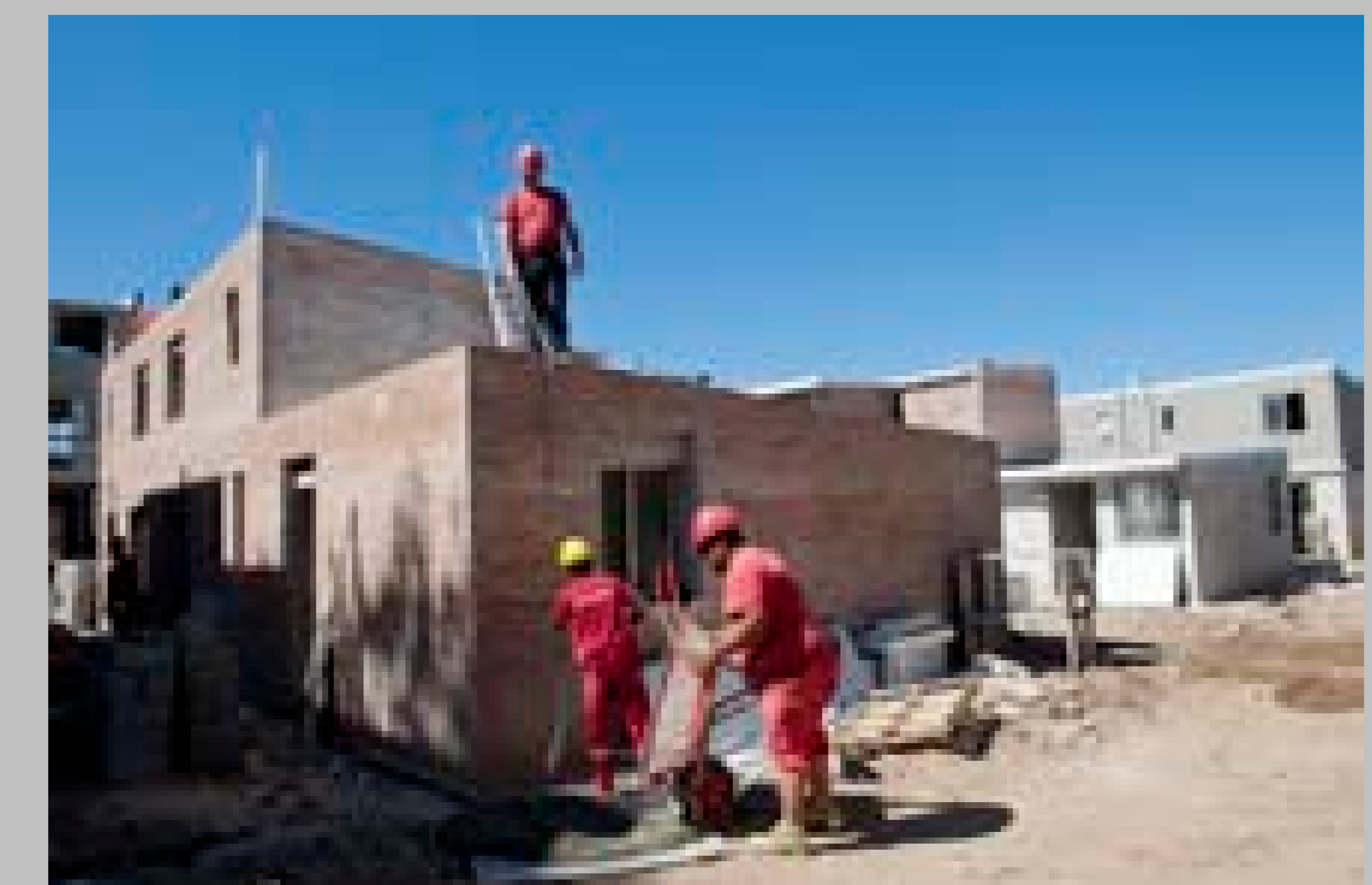
Construcción de viviendas para los habitantes del asentamiento Siete Manzanas. Esquina de las calles Juan Quevedo y Barros Arana. 18 de diciembre de 2014. (Foto: 52041FMCMA.CDF.IMO.UY - Autor: Carlos Contrera/CdF).
