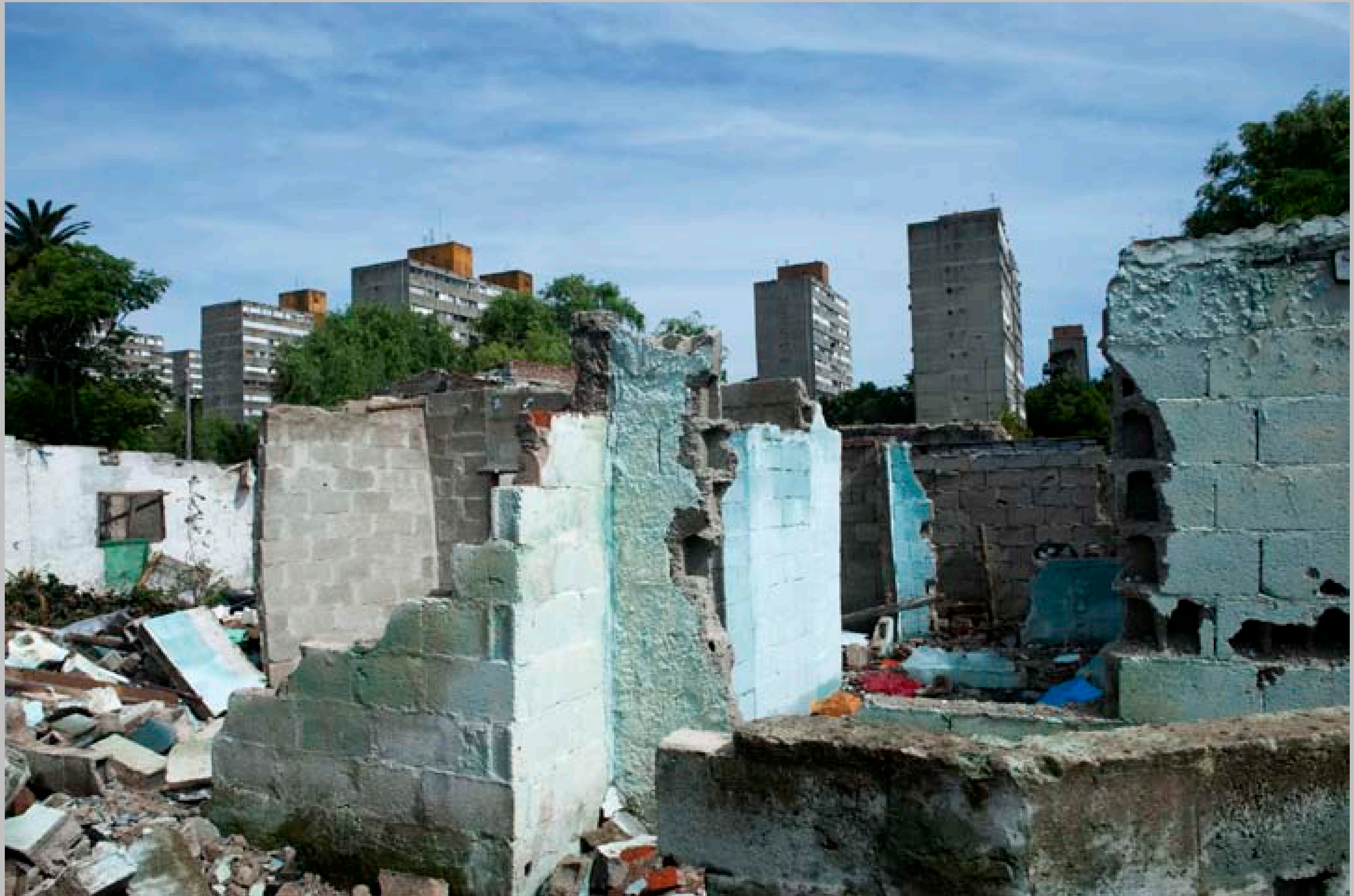
Viviendas demolidas en el asentamiento Candelaria. 21 de diciembre de 2012. (Foto: 36942FMCMA.CDF.IMO.UY - Autor: Carlos Contrera/CdF).
