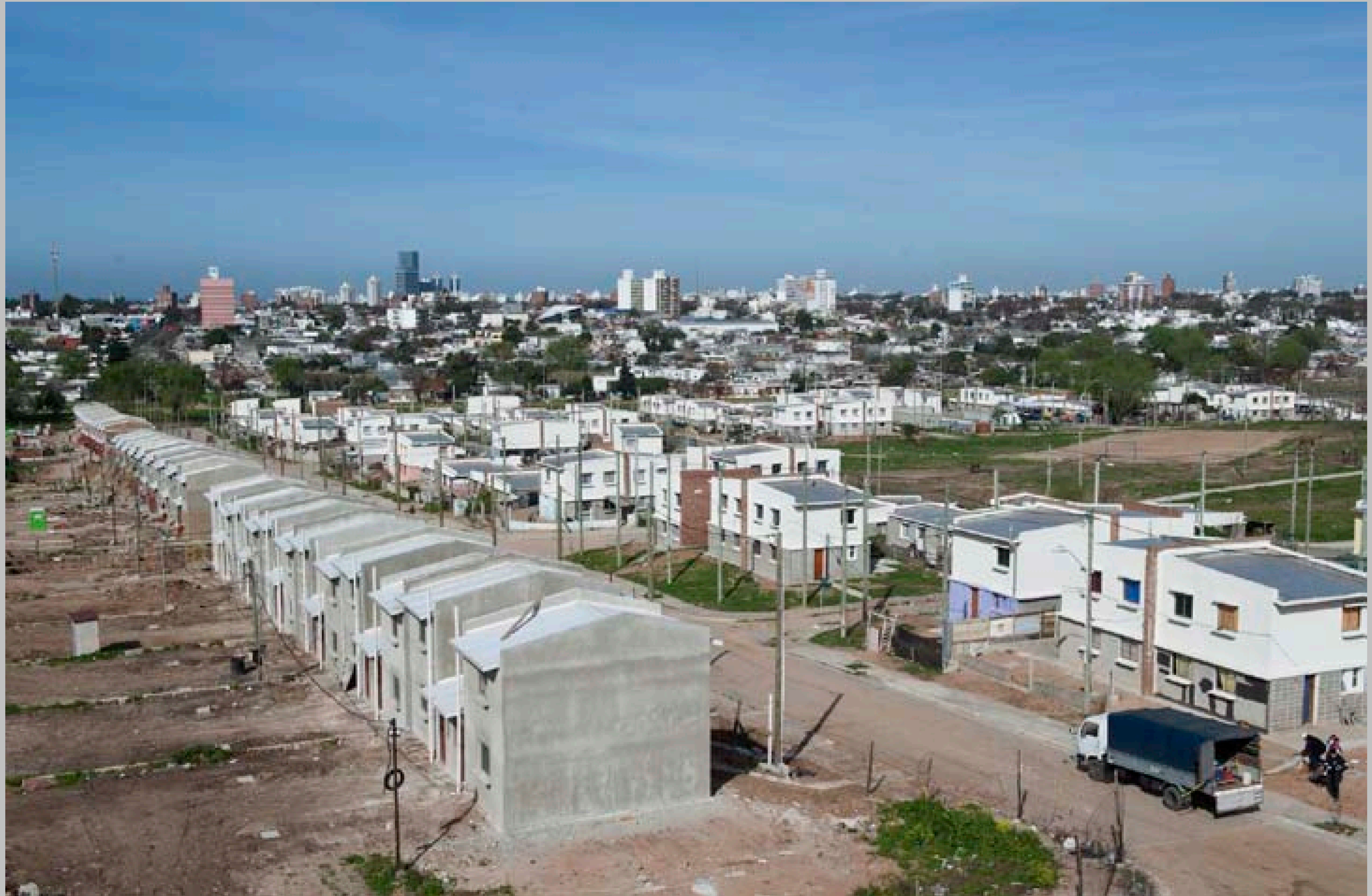
A la izquierda: Complejo habitacional Nueva Vida, destino de cuarenta y ocho familias del asentamiento Candelaria. A la derecha: complejo de viviendas construidas para el realojo del asentamiento Boix y Merino. Calle 6 entre la rambla Euskalerría y Espronceda. 11 de setiembre de 2012. (Foto: 36341FMCMA.CDF.IMO.UY - Autor: Carlos Contrera/CdF).
