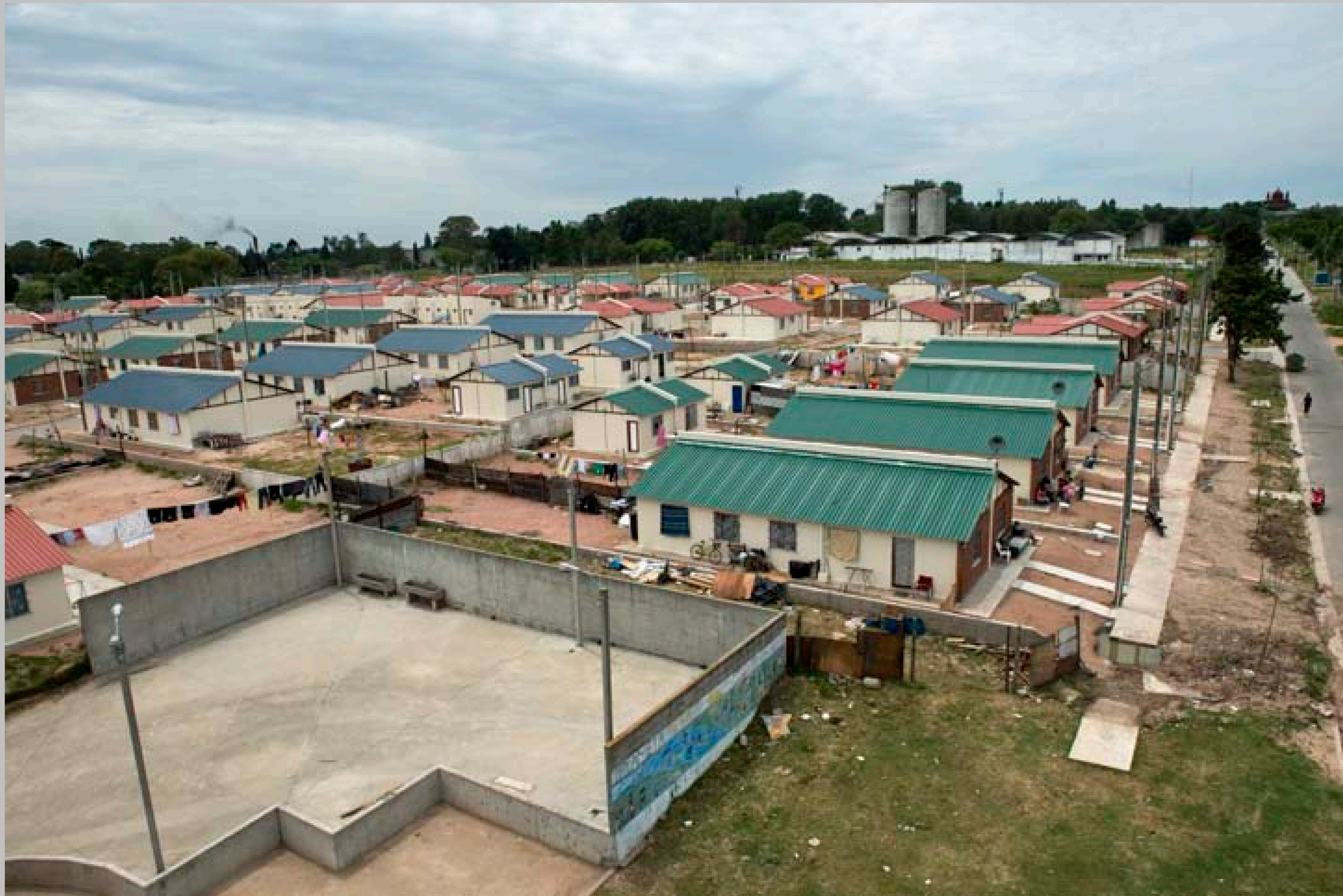
Viviendas construidas para el realojo de los asentamientos Paso de las Duranas y Joanicó. Esquina de la rambla Costanera del arroyo Miguelete y la calle Francisco Pla. 12 de diciembre de 2014. (Foto: 52203FMCMA.CDF.IMO.UY - Autor: Carlos Contrera/CdF).
