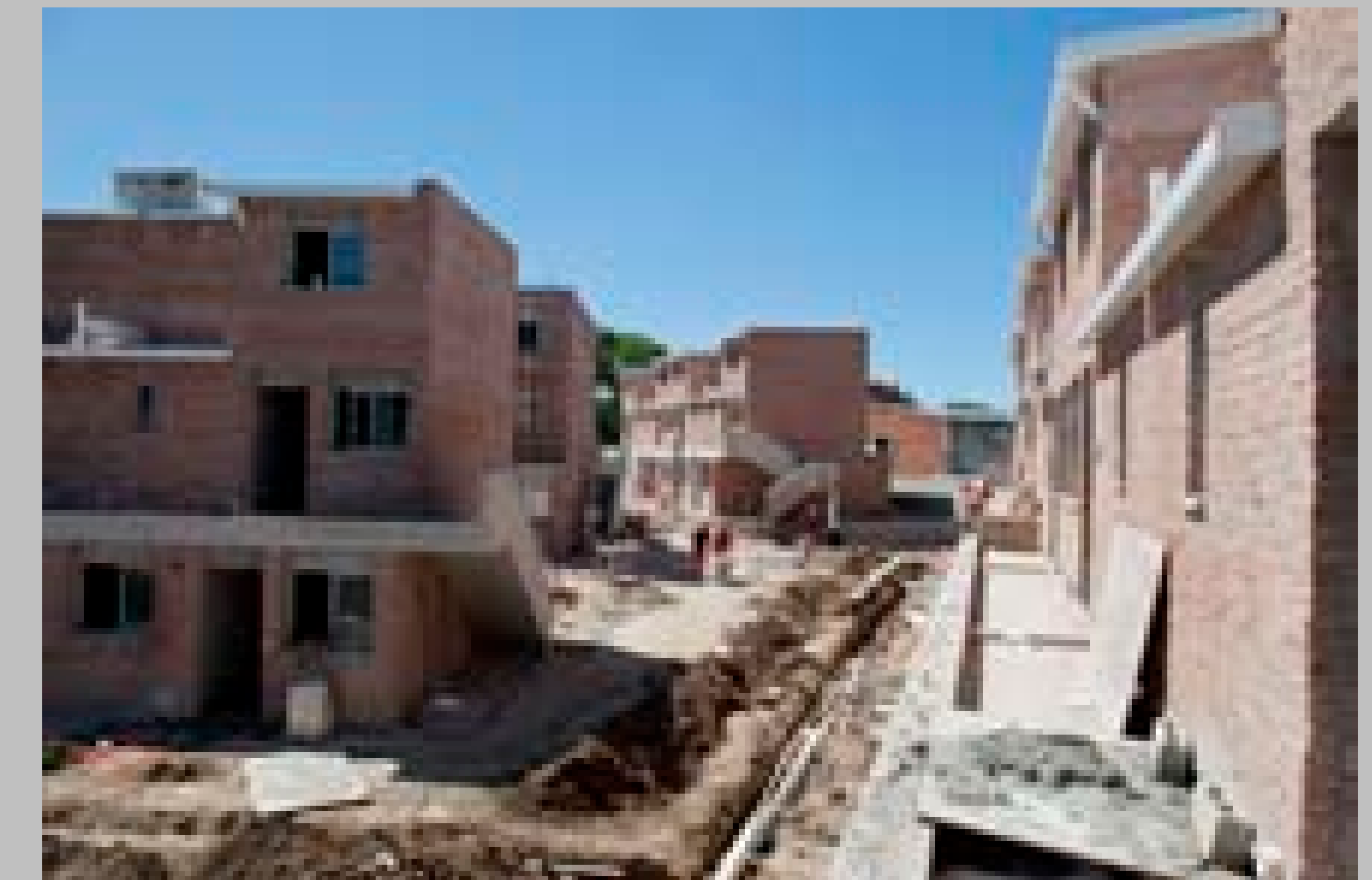
Construcción de viviendas para los habitantes del asentamiento Siete Manzanas. Esquina de las calles Argerich y José de Béjar. 18 de diciembre de 2014. (Foto: 52054FMCMA.CDF.IMO.UY - Autor: Carlos Contrera/CdF).
