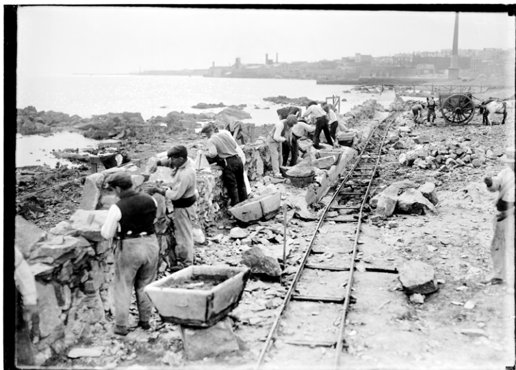
Construcción del muro de contención de la Rambla Sur. Al fondo: caño de saneamiento de la calle Paraguay. Años 1923-1926 (aprox.). (Foto: 18607FMHGE.CMDF:IMM.UY - Autor: S.d./IM).
