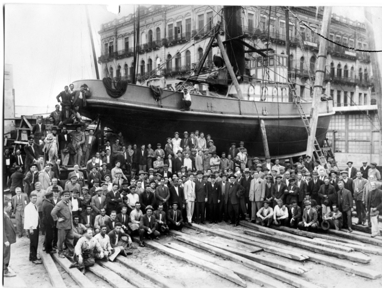
Festejo por el fin de los trabajos de construcción del remolcador Antonio D. Lussich. Al fondo: Edificio del Hotel Nacional. Astillero de la Administración. Puerto de Montevideo. Noviembre de 1931. (Foto: UY-ANP-AF-ANG107 - Autor: S.d).
